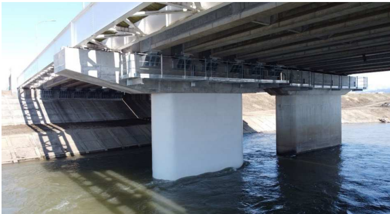
■国道102号橋梁補修(弘南大橋(下り))工事_弘前市 完成検査：令和5年3月31日
