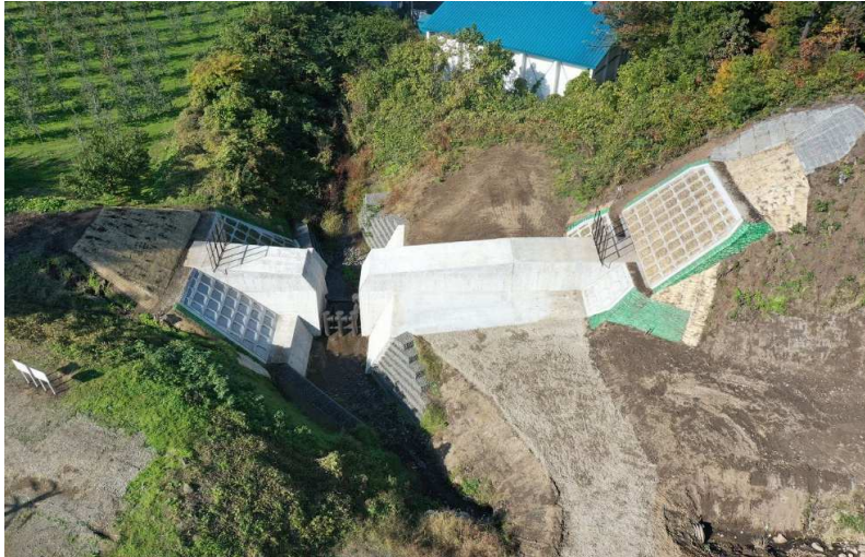
■ 泉山沢通常砂防工事_三戸町 完成検査：令和4年11月4日
