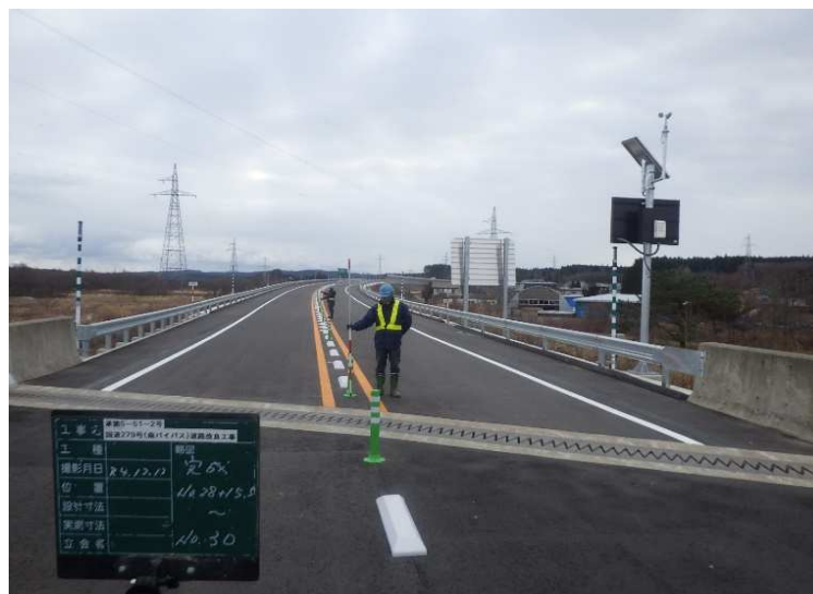
■ 国道279号(むつ南バイパス)道路改良工事②_むつ市 完成検査：令和5年1月30日
