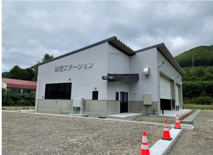
■川内佐井線道路改良事業除雪ステーション新築工事_むつ市 完成検査：令和4年8月9日
