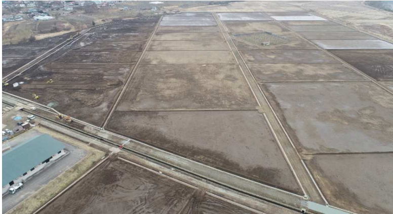
■名川第一工区県ぼ第10号工事_南部町 完成検査：令和5年3月23日
