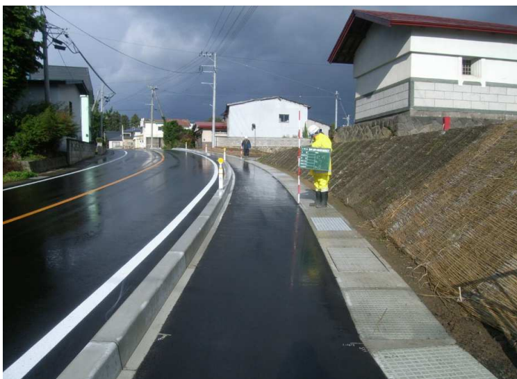
■弘前鱒ヶ沢線交通安全施設整備工事_弘前市 完成検査：令和4年11月9日
