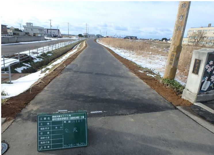
■金木川総合流域防災(加速化対策)工事_五所川原市 完成検査：令和5年3月8日
