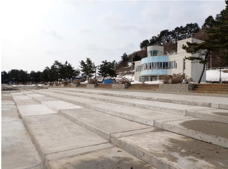
■陸奥湾沿岸地区(蟹田漁港海岸)海岸堤防等老朽化対策工事_外ヶ浜町 完成検査：令和5年3月6日
