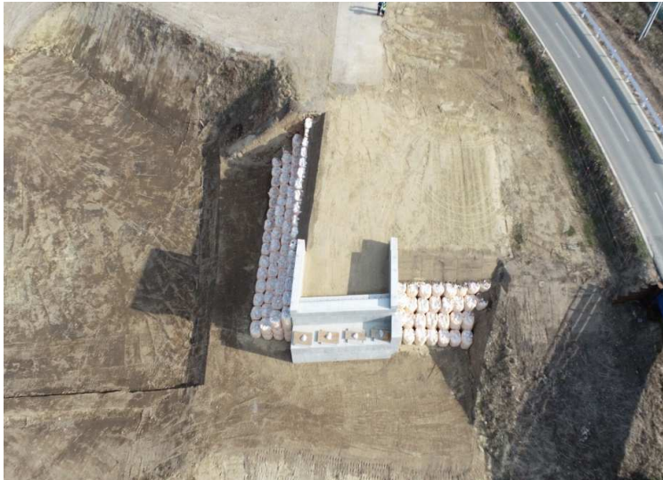
■金木川大規模特定河川工事_五所川原市 完成検査：令和5年3月30日
