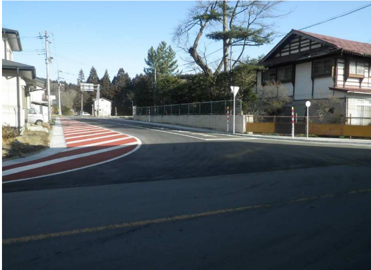
■戸来十和田線交通安全対策工事_新郷村 完成検査：令和5年3月23日
