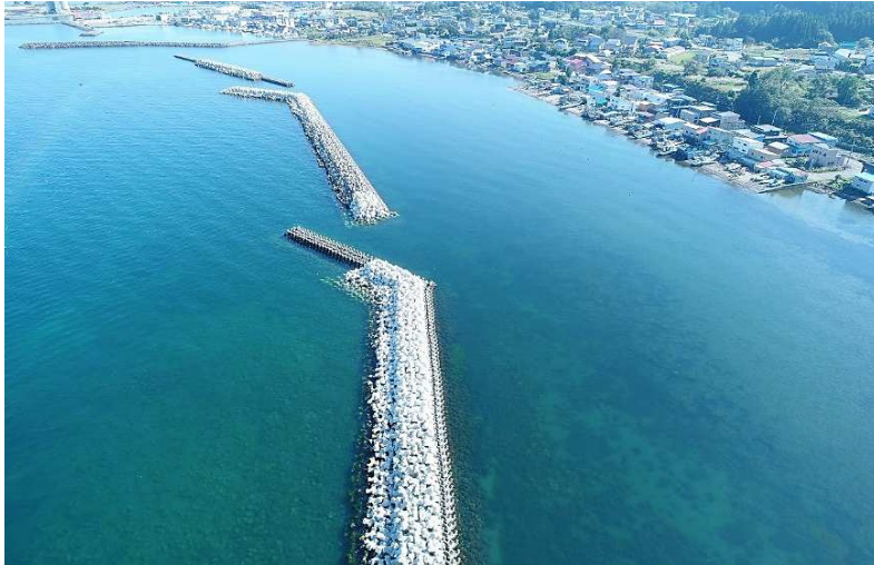
■野辺地港高潮対策(離岸堤嵩上げ)工事_野辺地町 完成検査：令和4年10月25日
