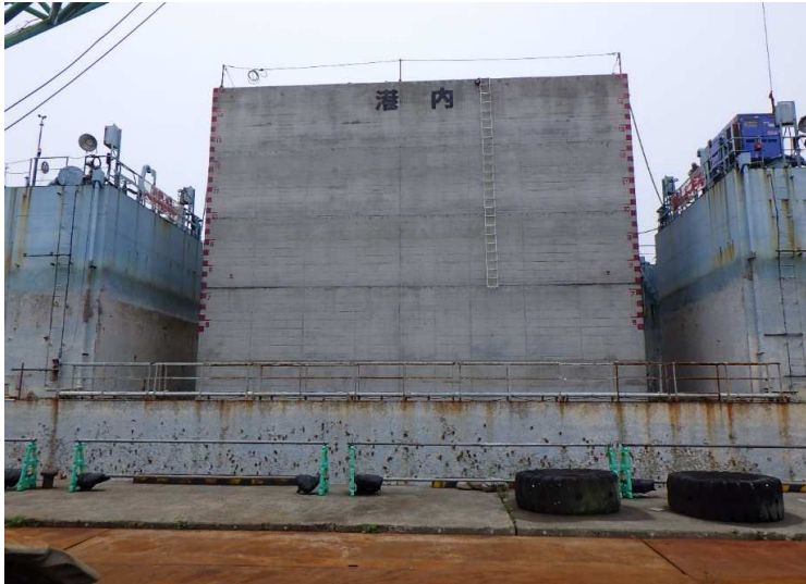
■佐井地区水産生産基盤整備工事_佐井村 完成検査：令和4年7月27日
