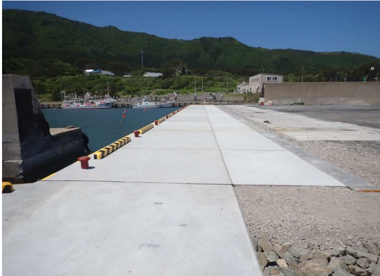
■尻屋地区水産生産基盤整備工事_東通村 完成検査：令和4年6月30日
