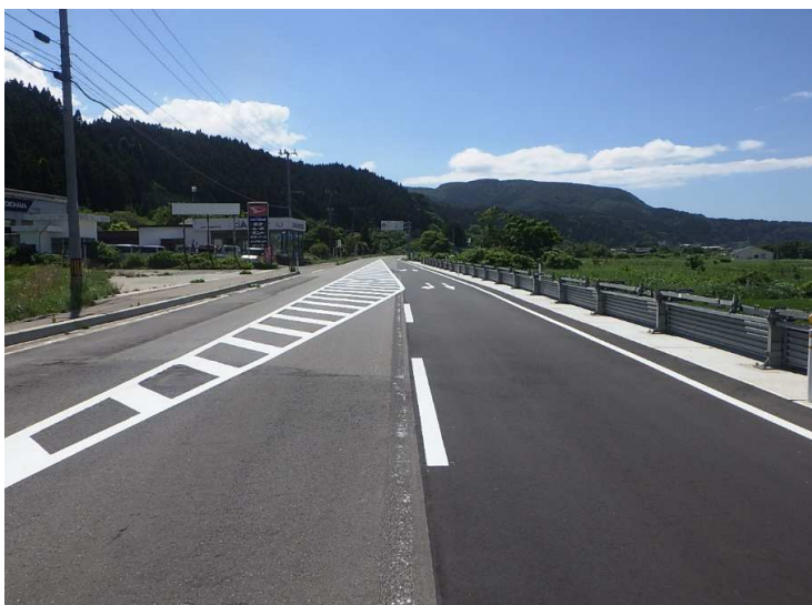
■西海広関第31号工事_深浦町 完成検査：令和4年7月12日
