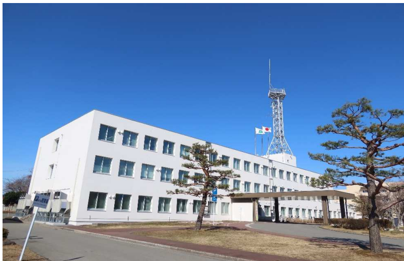
■十和田合同庁舎大規模改修工事_十和田市 完成検査：令和5年3月28日
