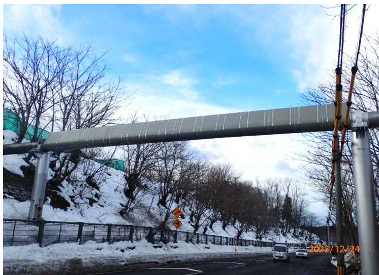
■金沢水管橋第2号工事_七戸町 完成検査：令和5年1月27日
