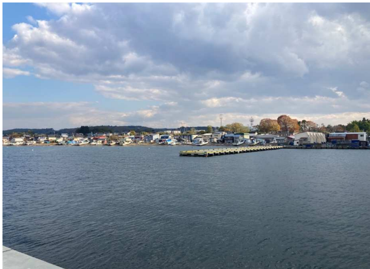
■野辺地地区水産生産基盤整備工事_野辺地町 完成検査：令和4年12月6日
