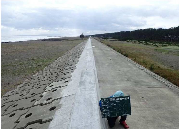
■百石海岸津波危機管理対策工事_おいらせ町 完成検査：令和4年11月17日
