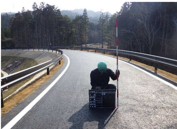
■古野・大川目線道路改良(県代行)工事_風間浦村 完成検査：令和5年3月16日
