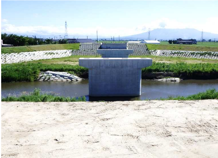
■五所川原黒石線橋梁整備(梅田橋)工事_五所川原市 完成検査：令和4年8月10日
