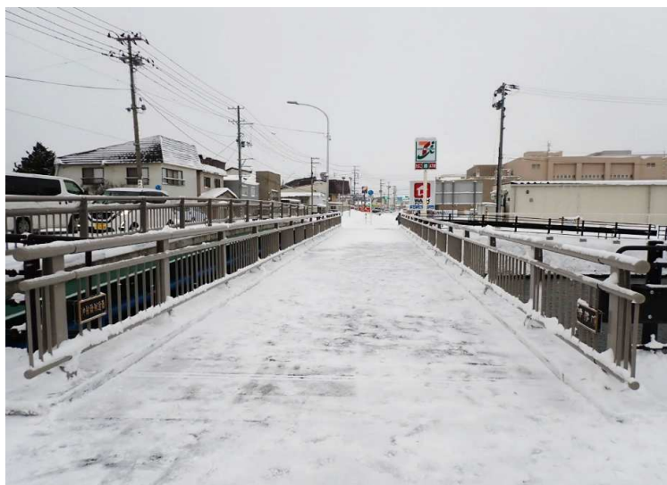
■国道280号道路改築(交安)工事_青森市 完成検査：令和4年12月21日
