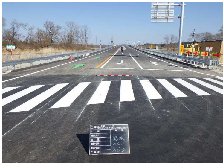
■ 国道279号(むつ南バイパス)道路改良工事①_むつ市 完成検査：令和5年3月24日
