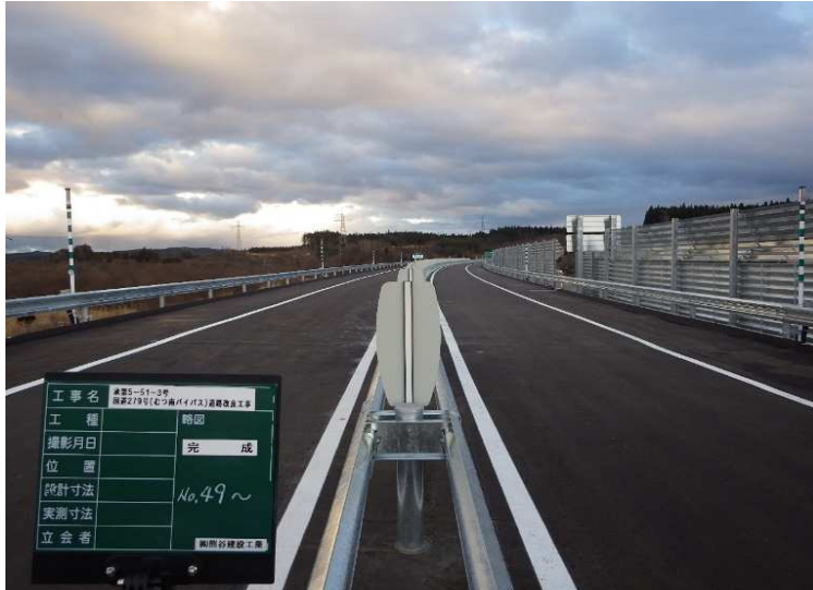
■国道279号(むつ南バイパス)道路改良工事③_むつ市 完成検査：令和5年3月22日
