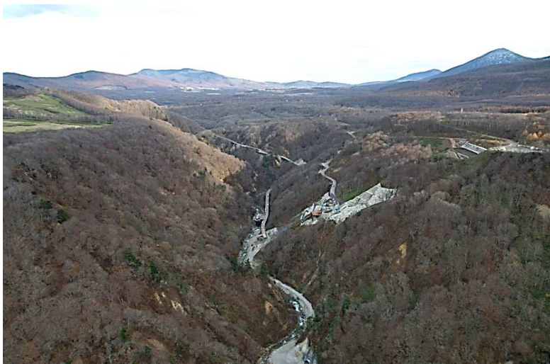
■ 駒込ダム本体建設工事_青森市 中間検査：令和4年11月11日
