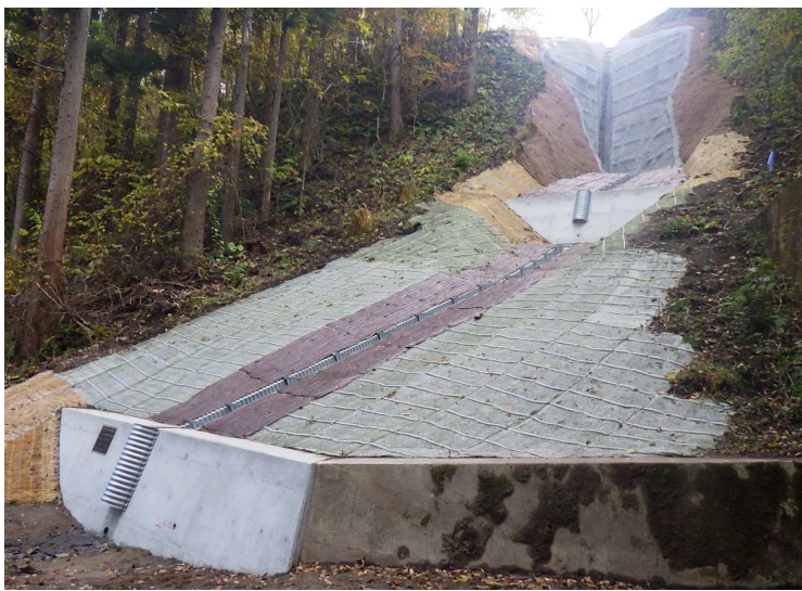
■令和3年度県営機能強化・老朽化対策工事_三戸町 完成検査：令和4年11月25日
