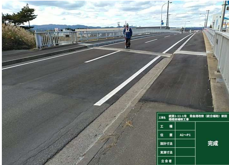
■青森港改修(統合補助)新田橋橋梁補修工事_青森市 完成検査：令和4年11月16日
