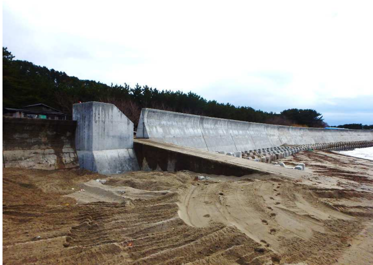
■大間越海侵第26号工事_深浦町 完成検査：令和4年12月8日
