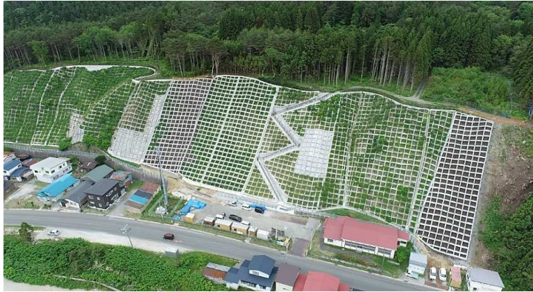
■ 甲平ノ下区域急傾斜地崩壊対策工事_風間浦村 完成検査：令和4年11月28日
