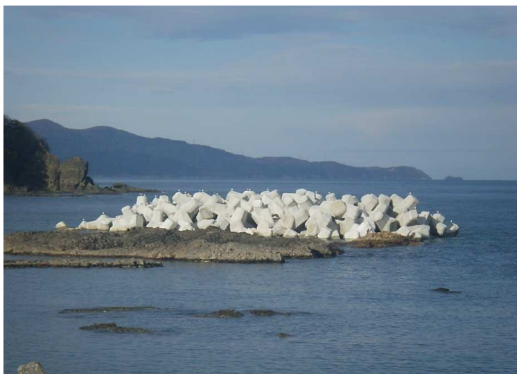
■一本木漁港海岸保全施設整備連携工事_今別町 完成検査：令和4年11月18日
