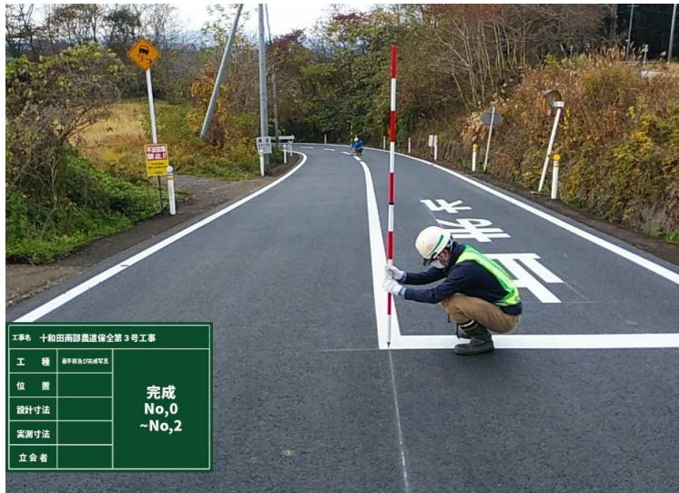
■十和田南部農道保全第3号工事_十和田市 完成検査：令和4年11月25日
