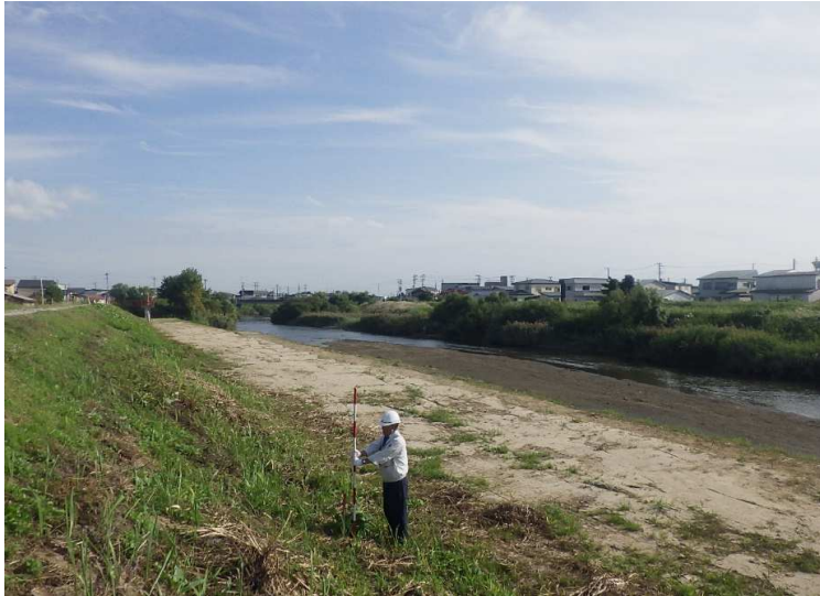
■旧十川外総合流域防災(加速化対策)工事_五所川原市 完成検査：令和4年10月11日
