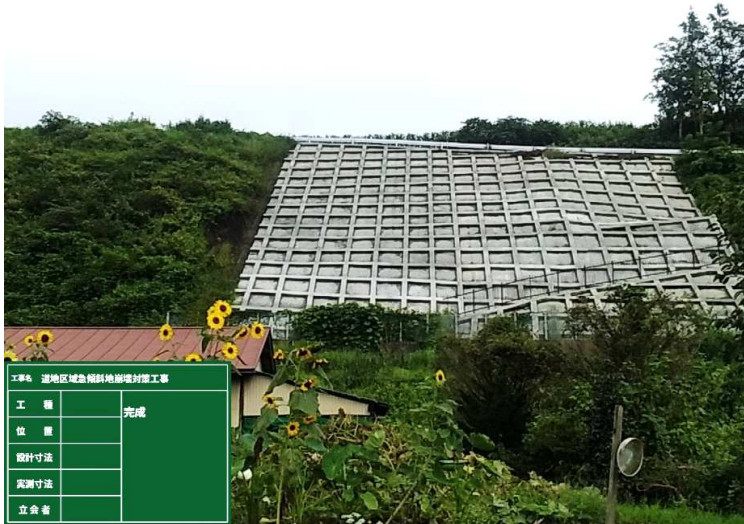
■道地区域急傾斜地崩壊対策工事_田子町 完成検査：令和4年9月8日
