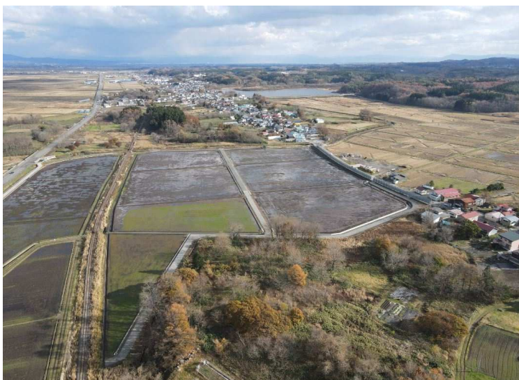
■狄ヶ館経営体第3,4工事_つがる市 完成検査：令和4年12月6,8日
