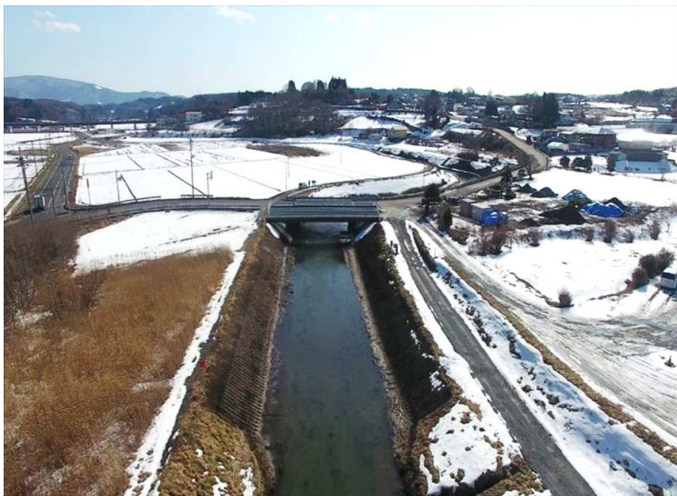
■ 松館川河床整理工事_八戸市 完成検査：令和5年3月9日
