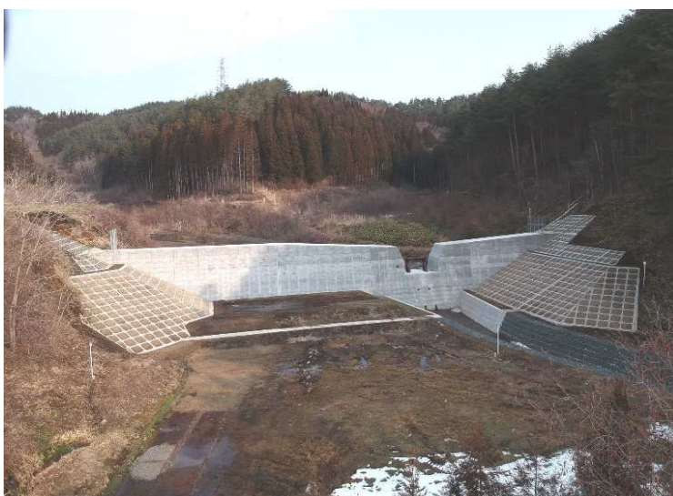
■ 内山沢火山砂防工事_五戸町 完成検査：令和5年3月17日
