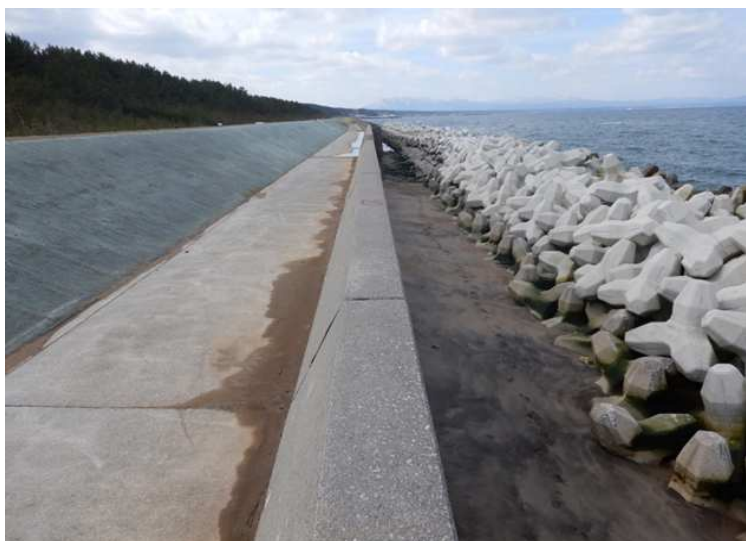
■令和3年度県営防災林造成工事_東通村 完成検査：令和4年10月28日
