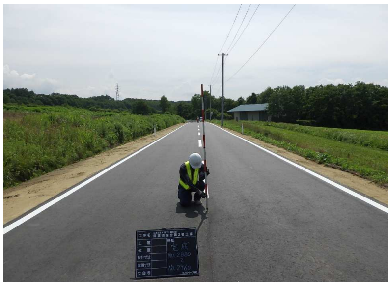
■館農道保全第2号工事_八戸市 完成検査：令和4年8月5日
