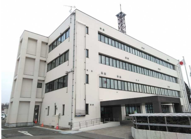
■財産建_むつ合同庁舎大規模改修工事_むつ市 完成検査：令和5年3月29日
