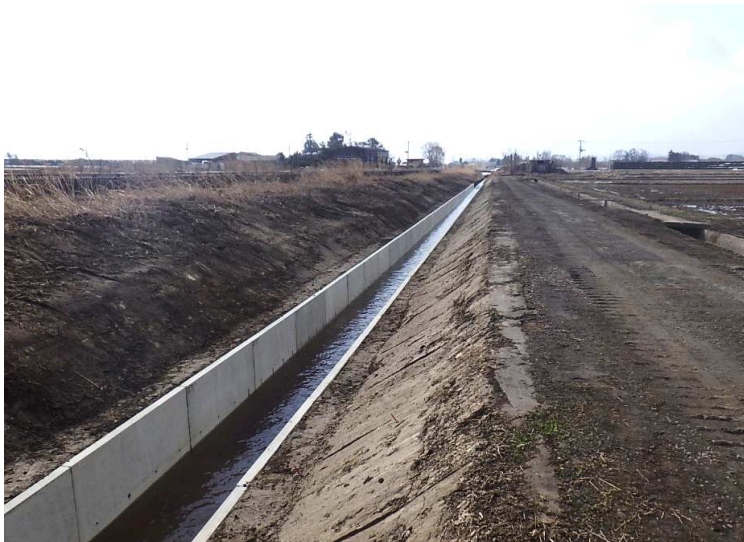
■水元長寿防災第1号工事_鶴田町 完成検査：令和5年3月24日
