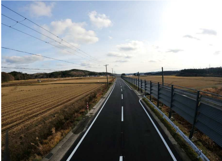
■ 鱒ヶ沢蟹田線広域連携交付金(舗装補修)工事_外ヶ浜町 完成検査：令和4年12月16日
