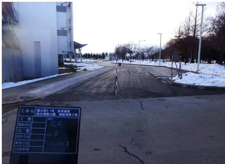
■新青森県総合運動公園舗装補修工事_青森市 完成検査：令和4年12月26日
