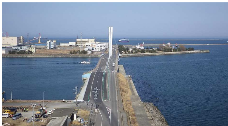
■八戸港改修シーガルブリッジ(取付道路改良)工事_八戸市 完成検査：令和5年3月29日
