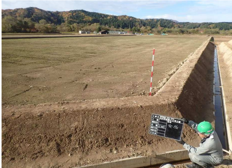
■大川平ほ第20号工事_今別町 完成検査：令和4年11月22日
