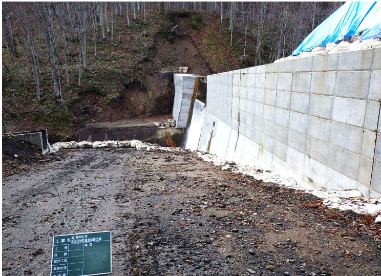
■冷水沢砂防堰堤修繕工事_十和田市 完成検査：令和4年12月23日
