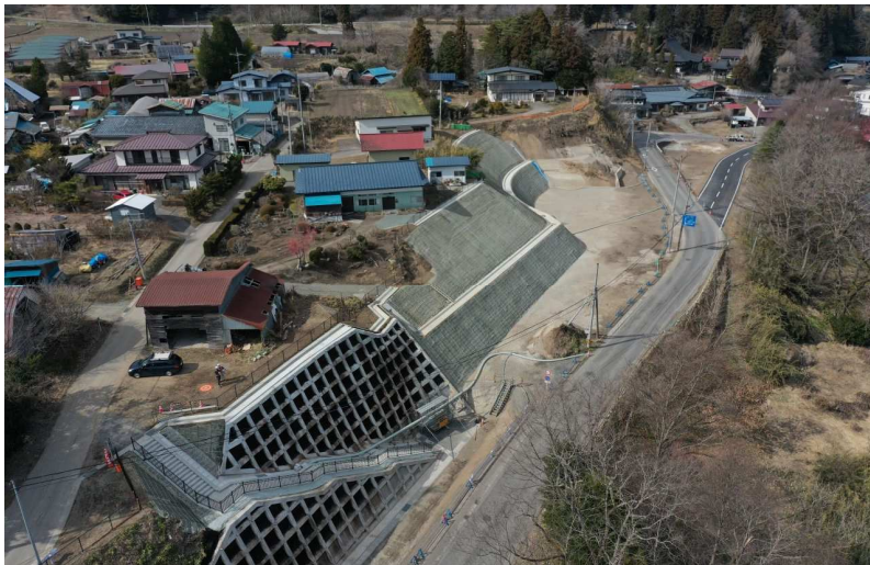
■国道454号交通安全施設整備工事_新郷村 完成検査：令和5年3月28日
