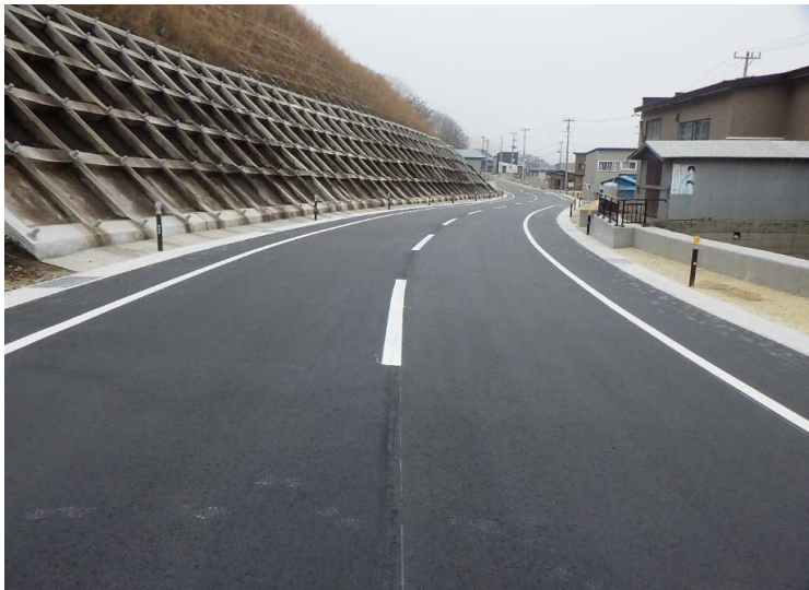
■ 国道280号交付金(道路改築)工事_今別町 完成検査：令和5年3月31日
