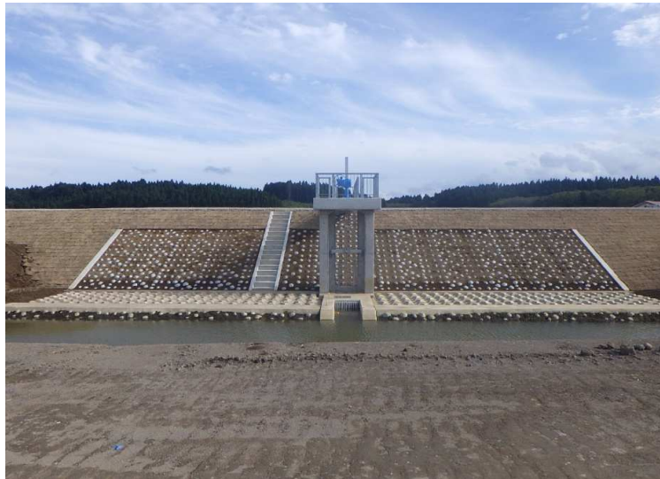
■ 高瀬川(七戸川)大規模特定河川改修(徳万才揚水機場)工事_東北町 完成検査：令和4年9月30日
