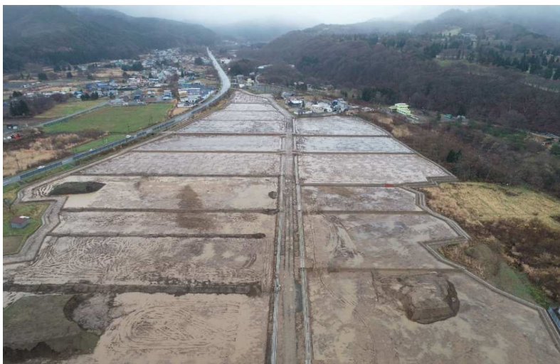
■ 三本木・滝沢ほ第2号工事_青森市 完成検査：令和4年12月23日
