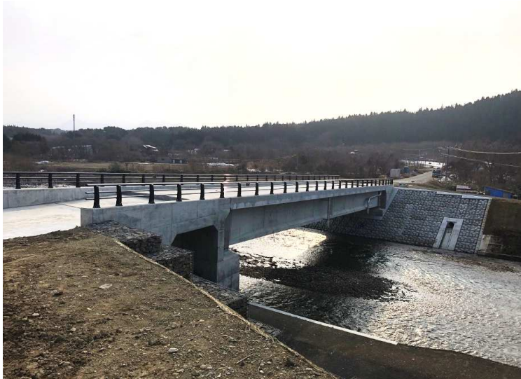
■三厩停車場竜飛崎線橋梁架替(新增川川橋)工事_外ヶ浜町 完成検査：令和5年3月16日
