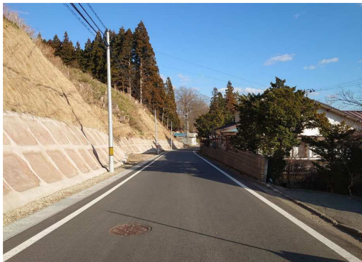
■石無坂鹿田線道路災害防除工事_新郷村 完成検査：令和4年9月30日
