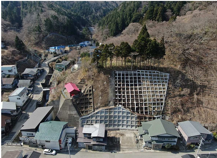
■ 令和4年度県営予防治山工事_外ヶ浜町 完成検査：令和5年3月31日
