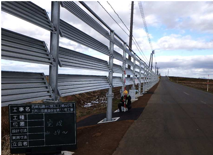
■五所川原農道保全第11号工事_五所川原市 完成検査：令和4年12月22日
