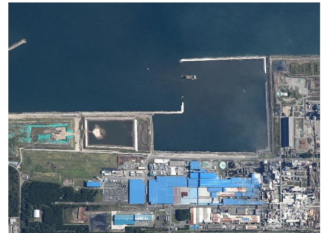
浚渫土砂処分場（八戸港八太郎地区市川）
