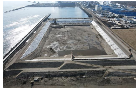
浚渫土砂処分場(八戸港八太郎地区市川)
