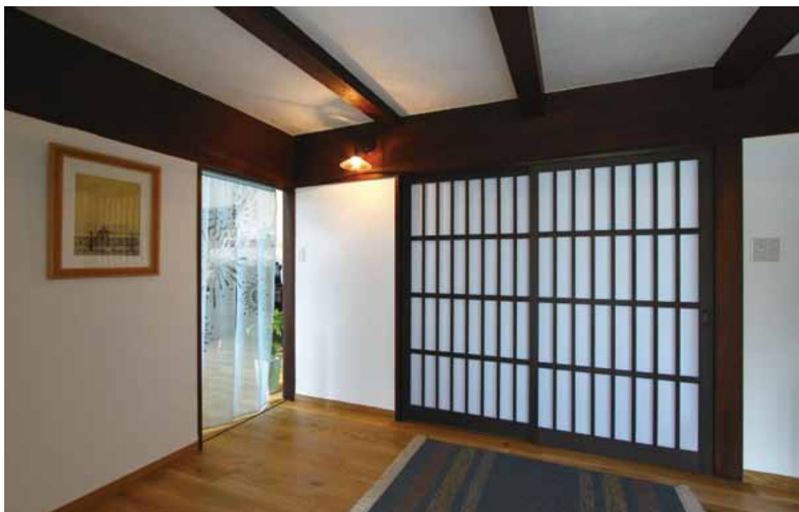
立派なヒバの差鴨居が天井を取り囲む玄関ホール
