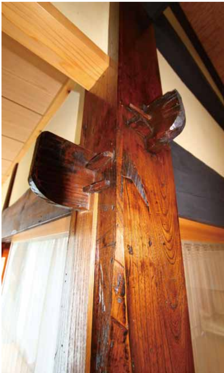
木の柱を打ち込んで堅牢に組まれた柱と差鴨居
