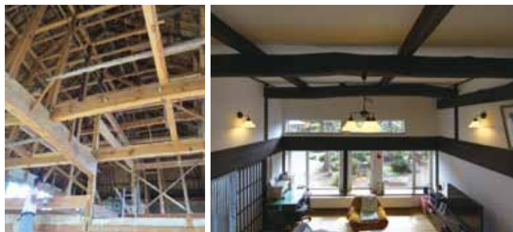
改修前は天井裏に隠れていた見えなかったマツの梁(左)と、リフォームして現わしに戻された天井(右)
