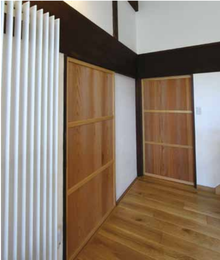
地中熱とヒートポンプを組み合わせた最新式の暖房システムのパネルヒーター（画面左）
