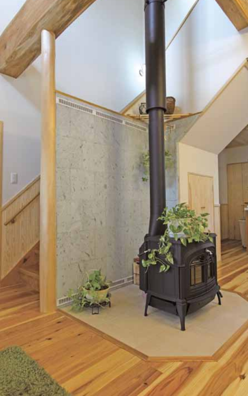
リビングのシンボルになっている薪ストーブ。これ1台で全室を暖める
