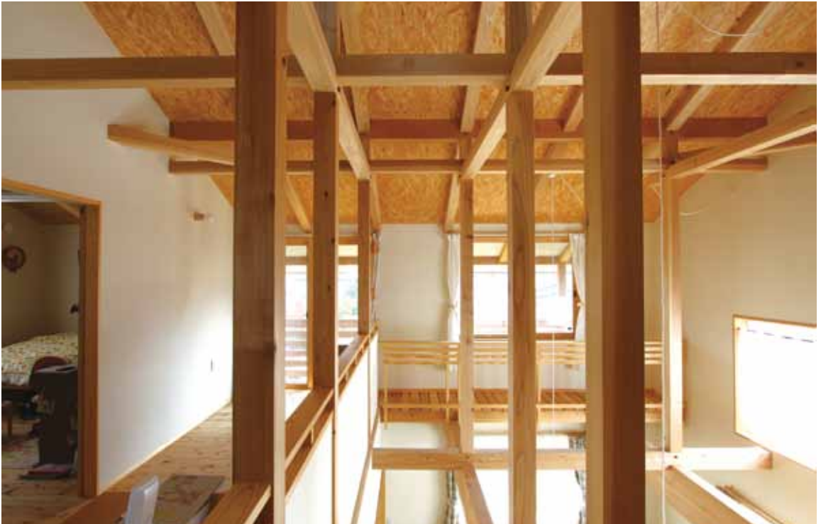
リビングの吹抜け部分には太い梁が交差する“木組み”の空間が広がる
