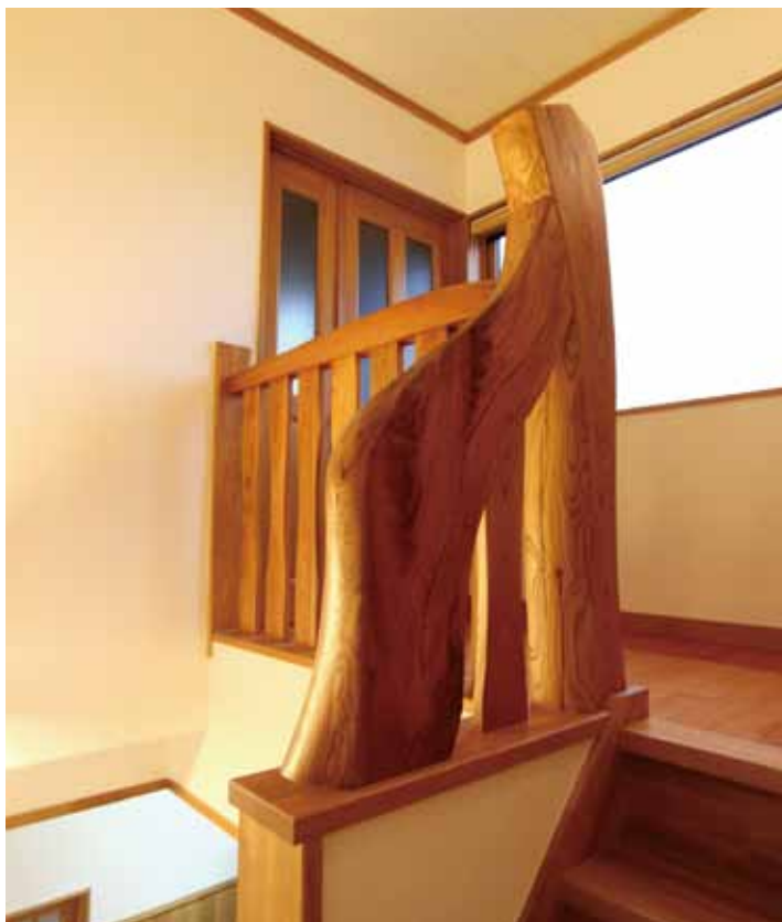
木の形状をそのまま活かした味わいのある階段の手すり
