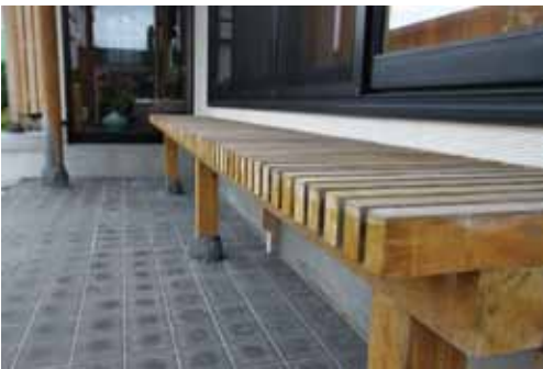
深い庇の下にあるヒバの濡れ縁
