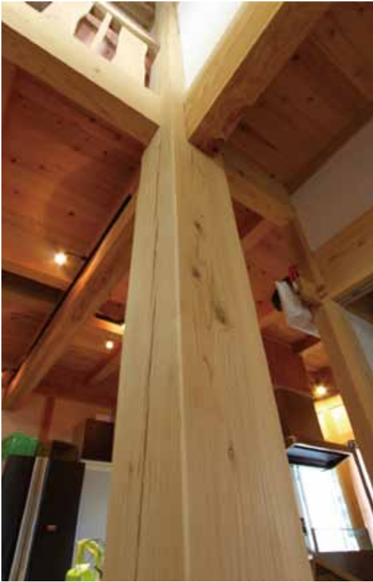
家を支える県産材の大黒柱
