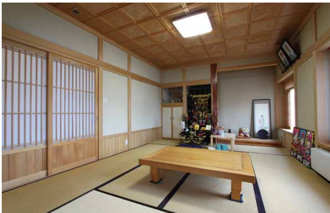
和室の建具や腰壁、天井にもすべてヒバが使われている
