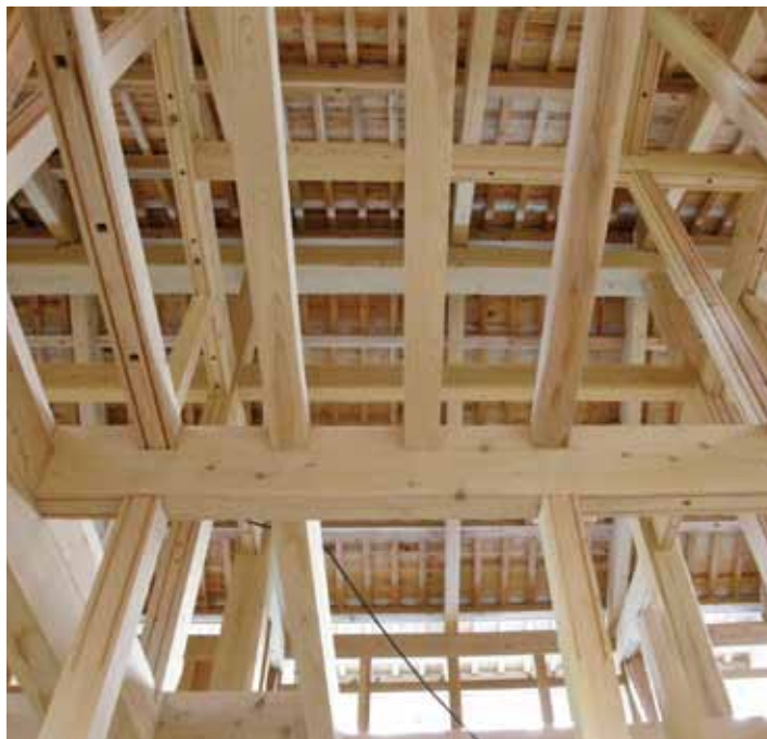
縦横に張り巡らされたアカマツの梁
