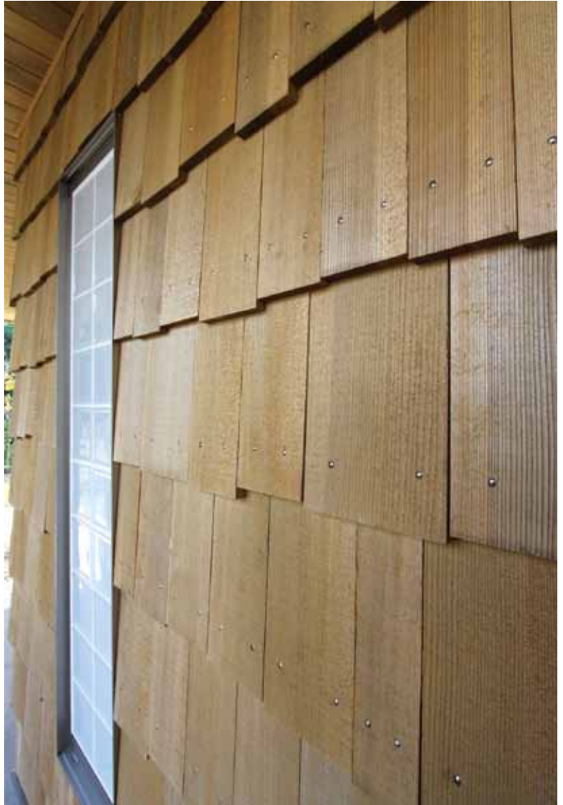
シェイク葺きの趣あるスギの外壁
