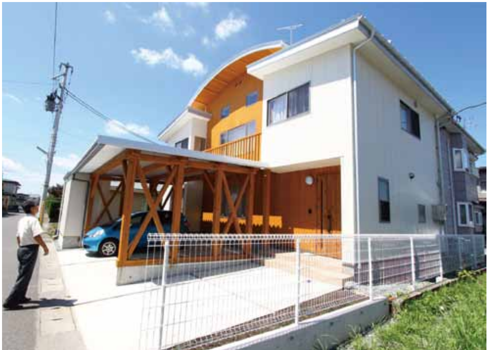
正面の一部にスギを張った外観
