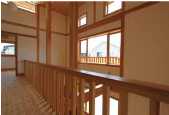
直射日光が入らないように、天井近くに取り付けられた明かり取りの窓
