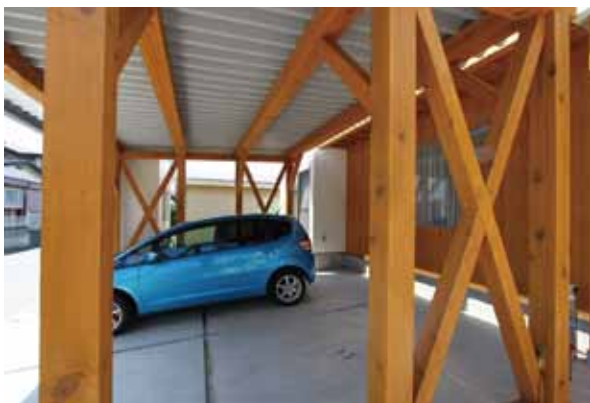
5寸角のスギ柱で支えられた開放的な車庫
