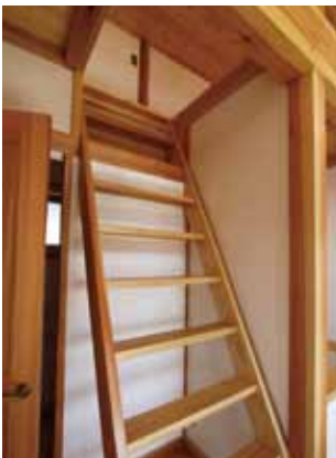
屋根裏スペース(上)とそこへ上る階段(下)
