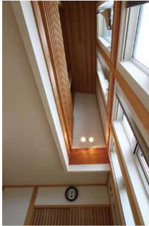
リビングの上に設けられた吹抜けは、明かり取りの役目も果たす
