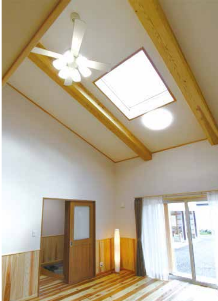
勾配天井の頑丈そうな登り梁と、暖かな陽光が射し込むトップライト
