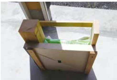
4寸角の柱を使用することで壁が厚くなり、断熱性能も向上
