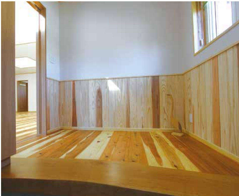
曲がりを生かした幅1尺のサクラの堂々たる上り框
