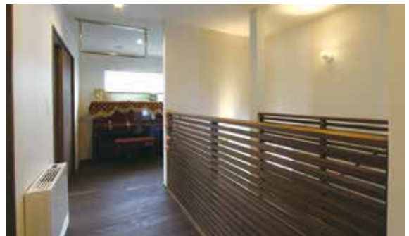
2階ホールの手摺りにも県産スギが使われている
