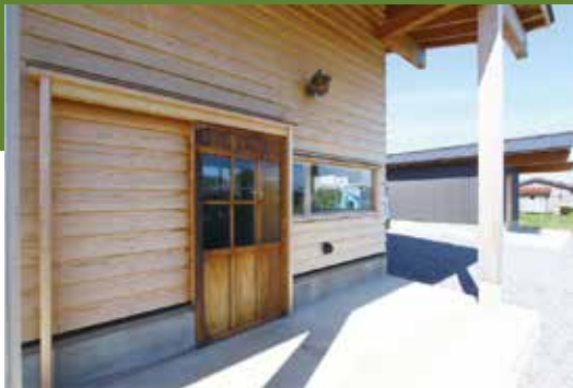
下見板張りの外壁が懐かしさを感じさせる外観
