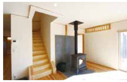
薪ストーブの暖かさが階段や「欄間建具」を通じて家全体に行きわたる
