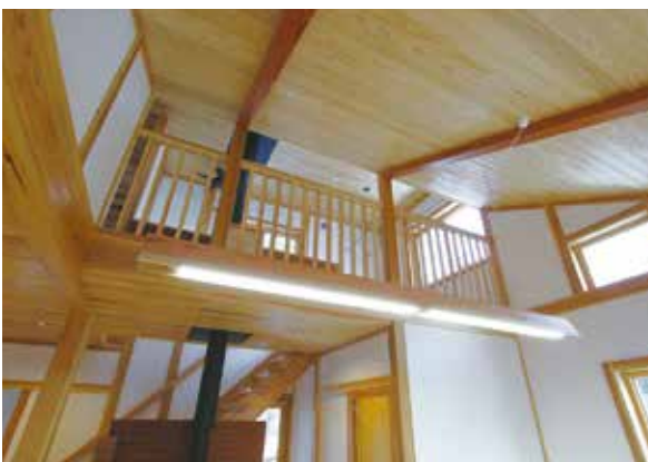
スギが張られたリビングの吹き抜けの勾配天井
