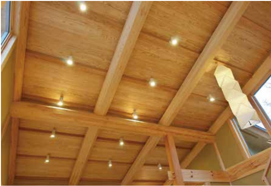
赤松の八角形の登り梁が現わしになった勾配屋根
