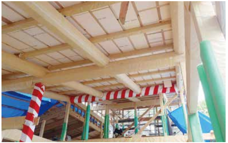
天井に現わしになった赤松の丸太梁が見るからに力強い
