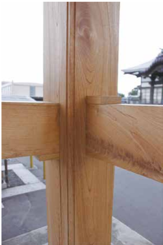
壁や筋交いを付けず「貫」の力だけで重い屋根と吊り鐘を支えている
