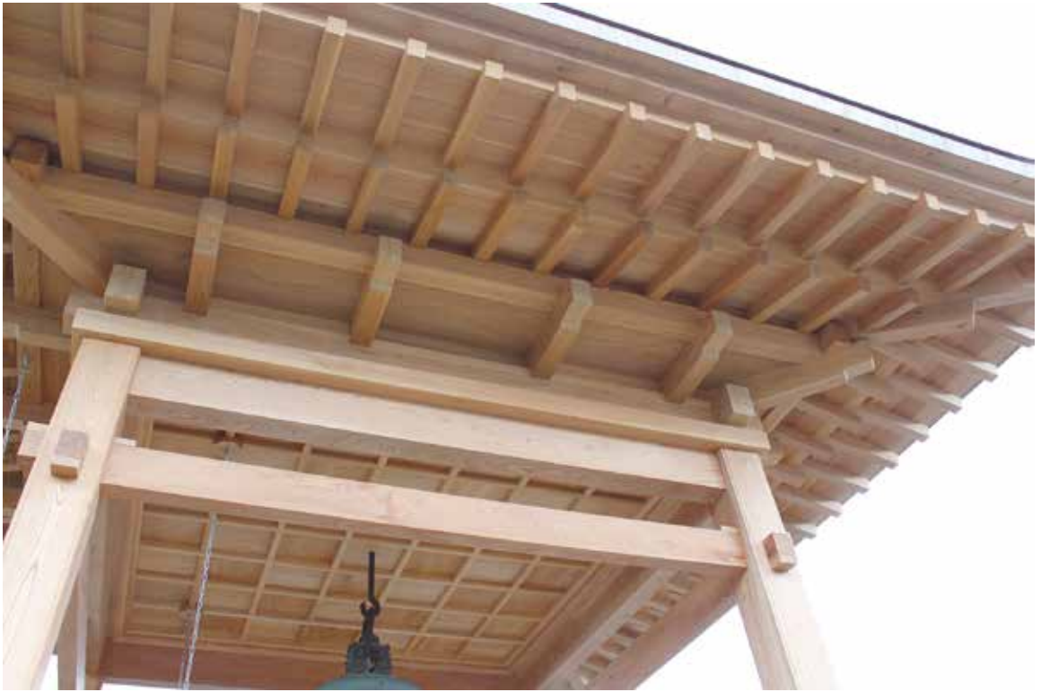
結木を入れた1間幅の屋根裏のスギの化粧垂木が美しい
