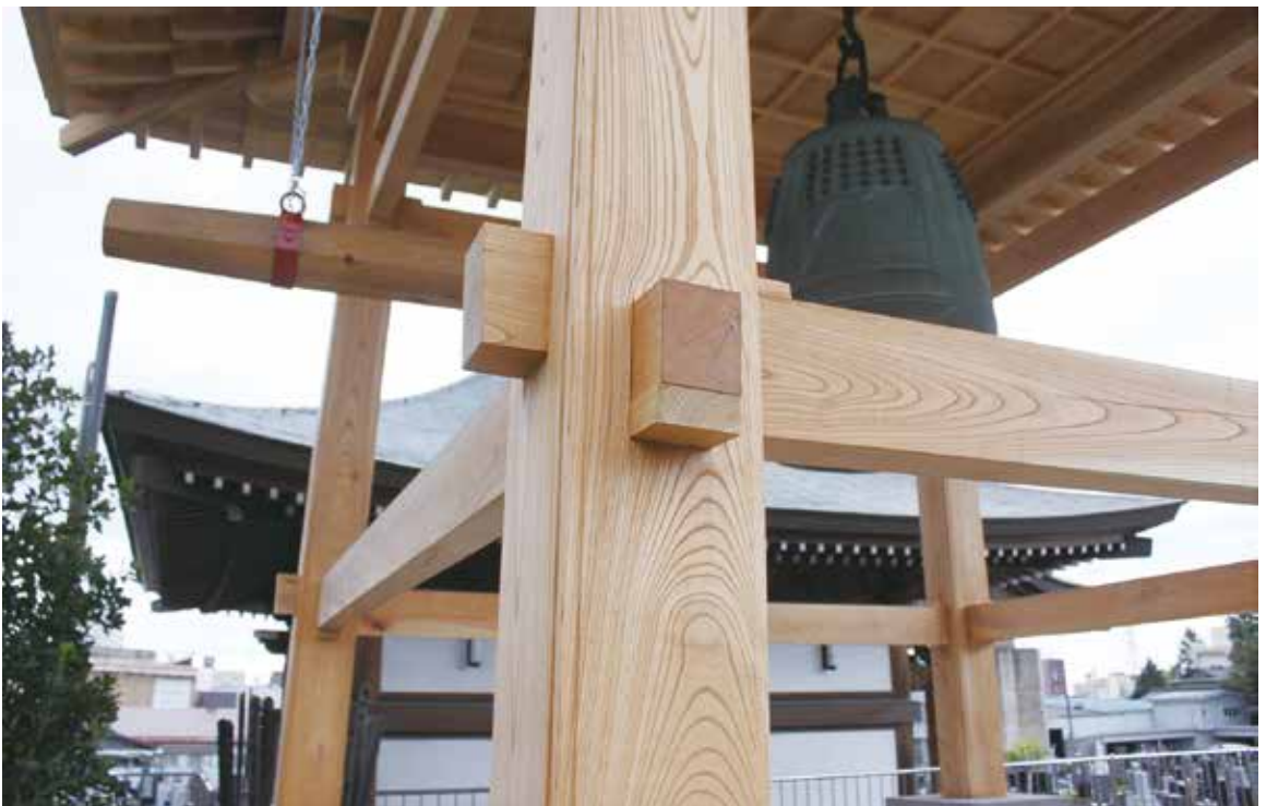
鐘樓の屋根を支える「貫」を通したケヤキの柱
