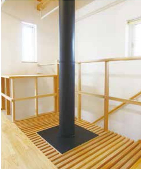
煙突まわりの格子状の床は、階段下の薪ストーブの熱が隙間を通して上がってきやすいようにと工夫されたもの
