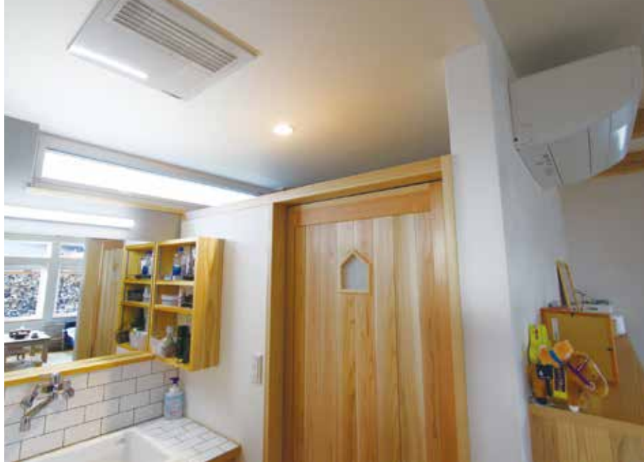
更衣室の戸の上部には冬に寒くならないように、薪ストーブの熱を取り入れるための隙間が開けられている
