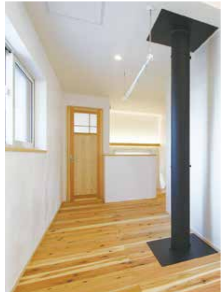
薪ストーブの煙突が2階をほんのりと暖めてくれる
