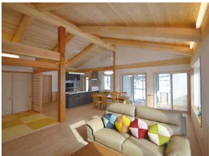
金具を使用しない梁組が大工の技術の高さをうかがわせる
