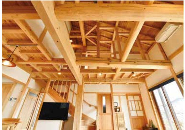
力強い梁が交差するリビングの開放的な吹抜け
