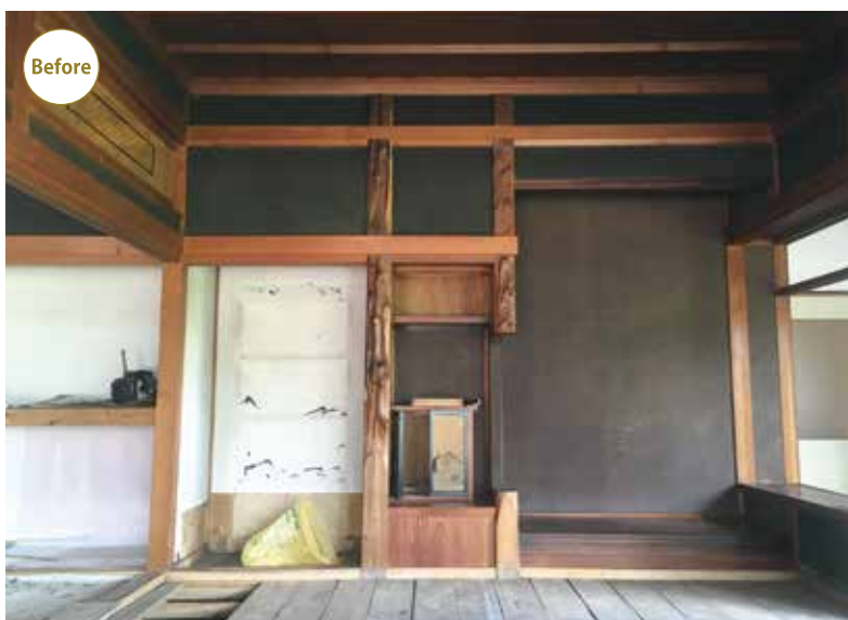
床柱を中央に移した改修後(上)、改修前は仏間は左端にあった(下)
