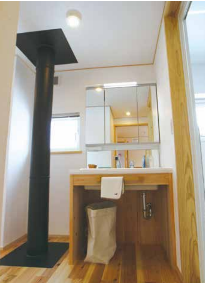
薪ストーブの煙突の熱で風呂上がりも寒くないという2階の洗面スペース
