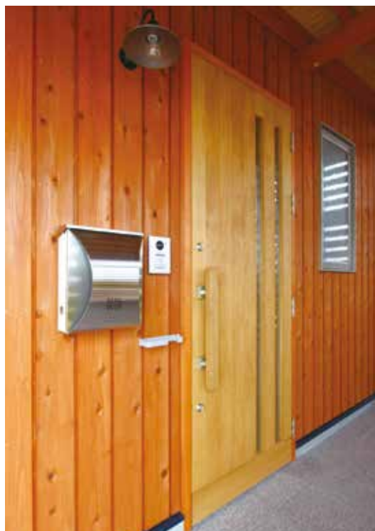
外壁にスギ板が張られた玄関ポーチ
