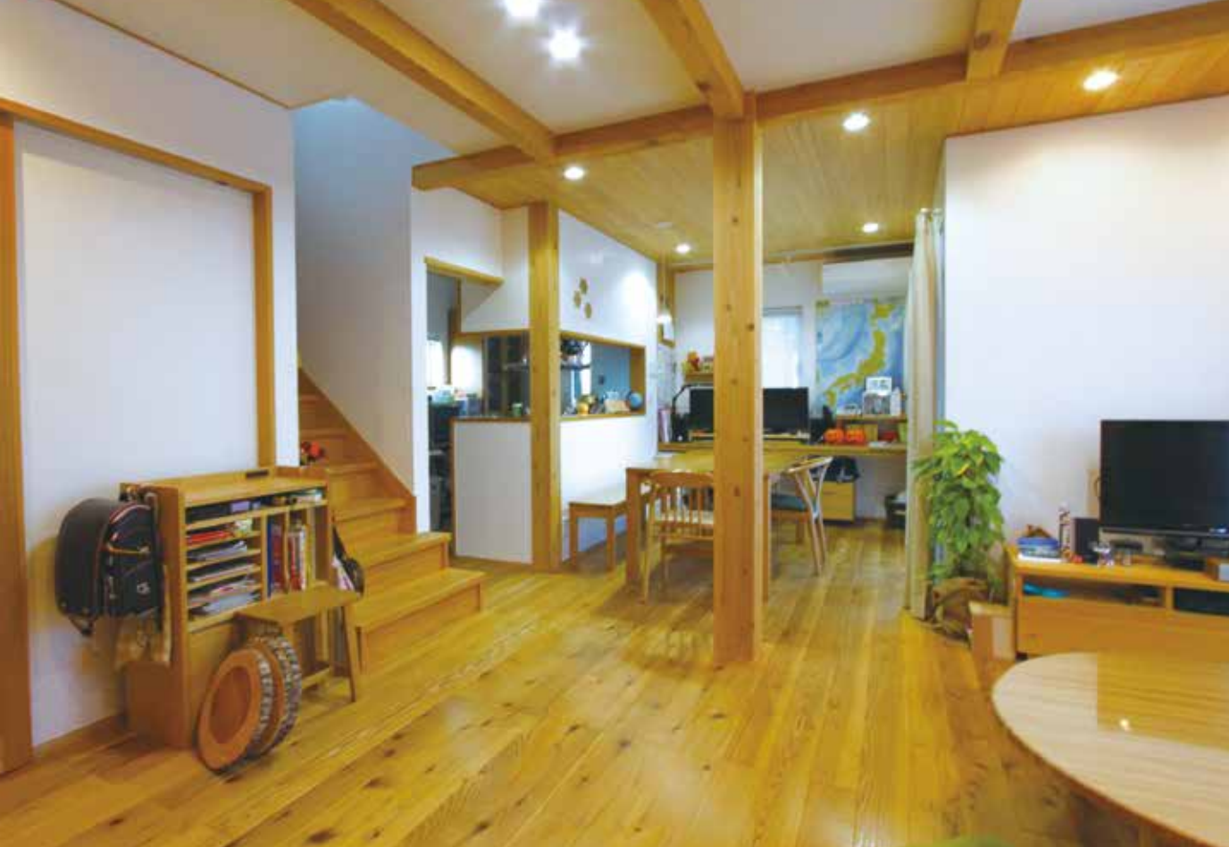
玄関土間から正面に広がるリビングに立つスギの大黒柱
