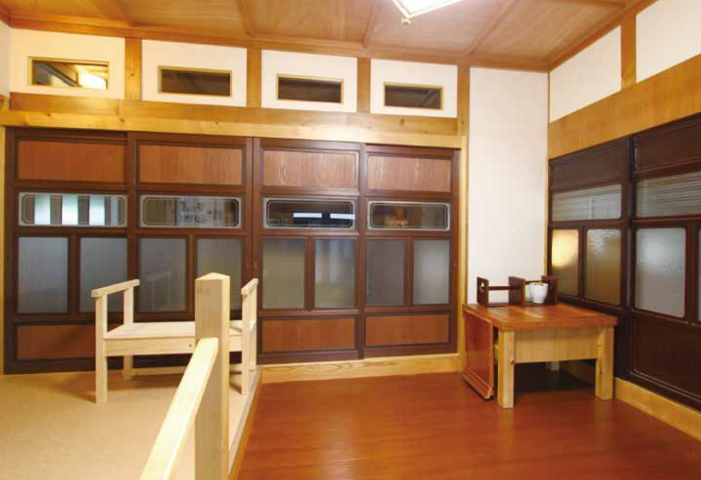
右側に建つ元のままの建具に合わせて正面の建具を造り直した玄関ホール
