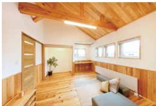
ハイブリッド温水暖房システムによって温められた温水をパネルヒーターに循環させている
