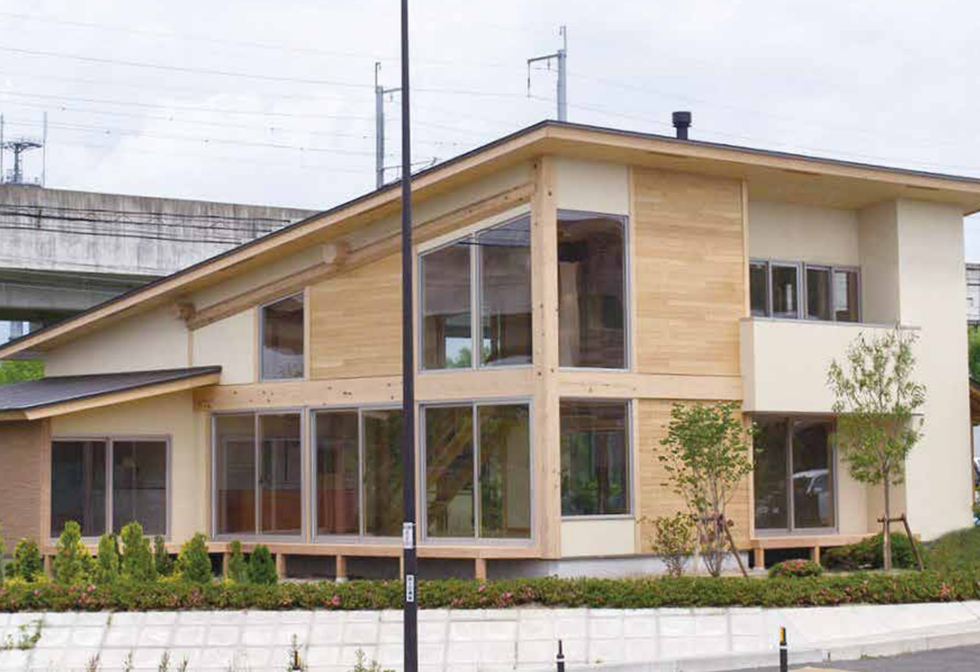
板壁の美しい外観に“ダイナミックで上質な木の空間”へ期待が高まる展示場
