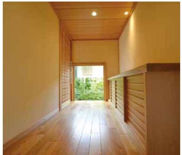
ケヤキの床板が張られた廊下の向こう、嵌め殺しのガラス越しに中庭が見える
