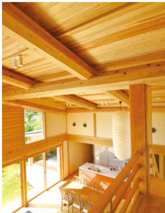
スギ板張りの勾配天井を支える八角形の登り梁が力強い
