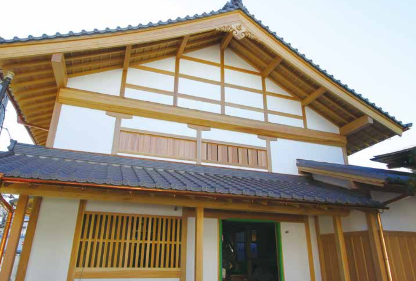
反り屋根の破風は南部赤松。桁や柱は杉。外観からだけでも木肌が美しい無垢材をふんだんに使っていることが分かる。室内の丸太梁や床、壁、天井など建物全体の材積となると一般住宅の10倍に上るとい
