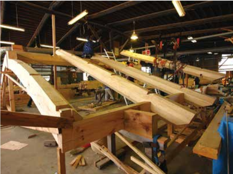
五戸町にある加工場の中で乾燥させた木材(上)と、手刻みした丸太梁を現場に搬入する前に行う地組 じくみ
