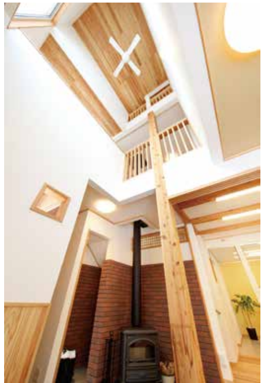
薪ストーブの熱が家中に行き渡るように設けられた吹き抜け
