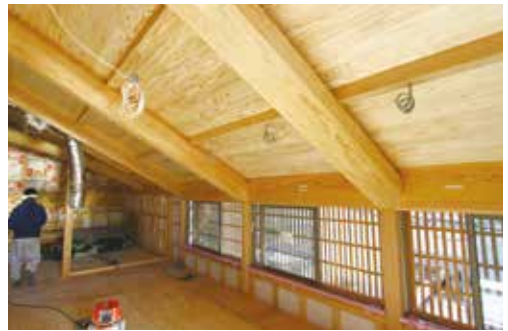
2階リビングの勾配天井にも八角形の登り梁
