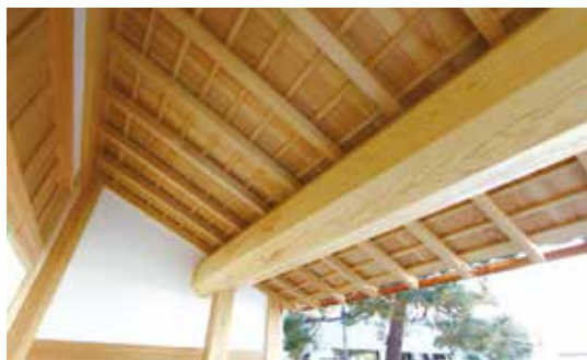
玄関前の下屋に架けた太い南部赤松の桁。化粧小屋裏の杉の柂目が美しい
