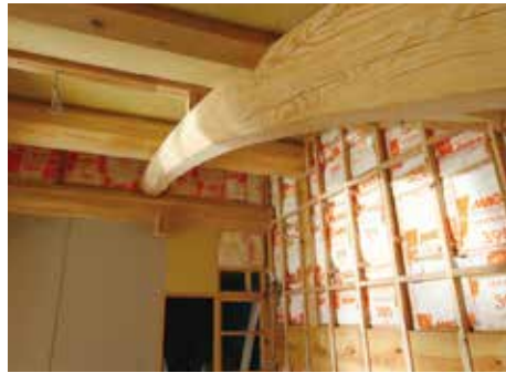
2階の納戸の天井に架けられた赤松の太鼓梁
