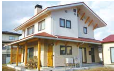
■種市様邸(八戸市白銀) 2016年12月竣工 延べ床面積/44.30坪(146.43㎡)
