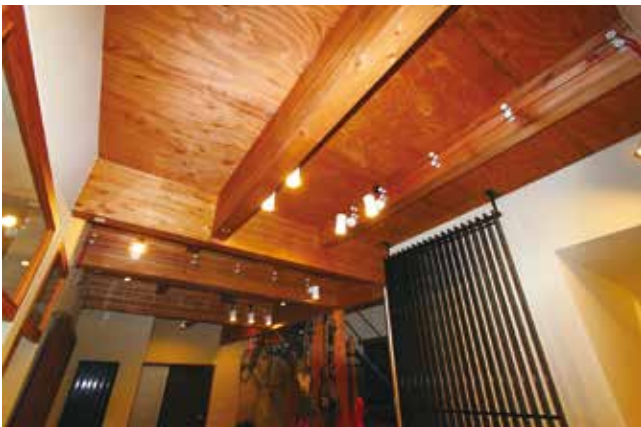
天井の白い陶器製の罫子を使った電気配線が“新しい古さ”を感じさせる
