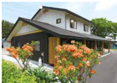
■中村様邸(十和田市奥瀬) 2013年4月竣工 延べ床面積/55.23坪(182.94㎡)
