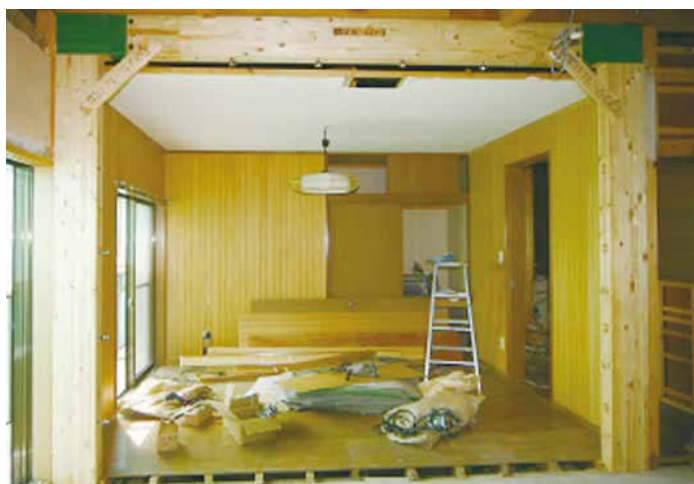
家全体ではなく、寝室とLDKの開口部に「開口フレーム」を設置することで災害時にゆとりをもって避難できる
