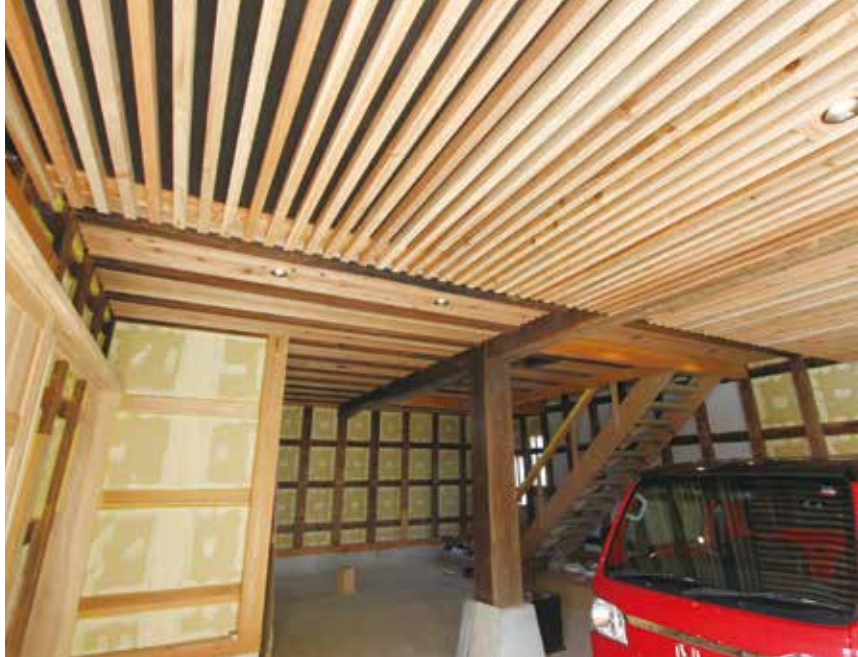
1階のガレージ。天井に張ったスギの格子が美しい
