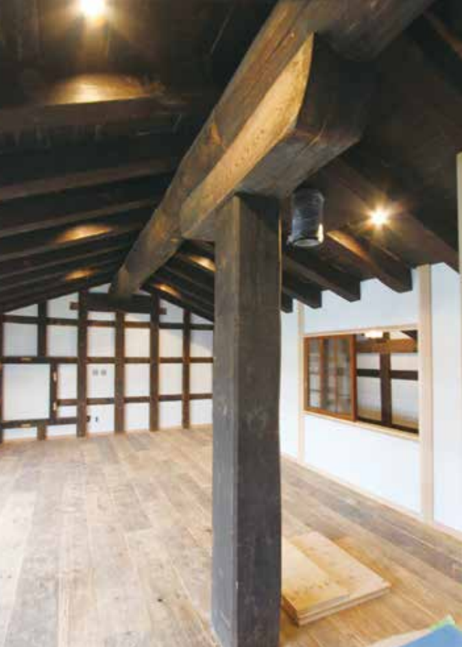
大黒柱のてっぺんにかかる棟木の荷重を分散させるために「肘木」が挟まれている
