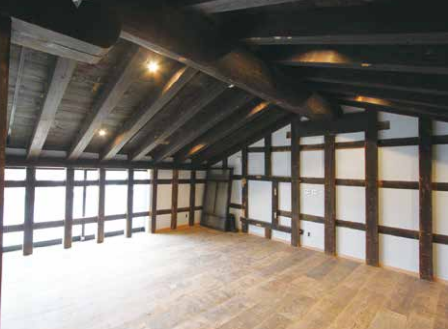
窓のように見える壁の「四角」は一つ一つ内法寸法が違うため、大工がそれに合わせて寸法を測り、下地の石膏ボードを切って張り付けた
