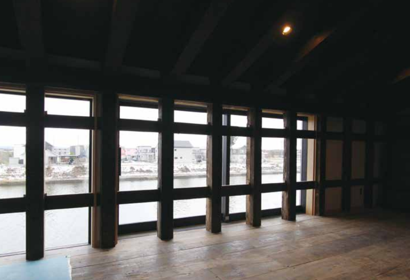
元の蔵だった風情が感じられる、新田名部川を望む大開口の窓。柱と貫が交差する外側にサッシ窓がある
