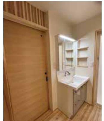
室内の暖房の暖かい空気が入るよう工夫された洗面所の上部の格子
