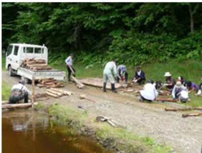
ビオトープ池に間伐材の木橋を設置するなど、地域で自主的な活動を展開
