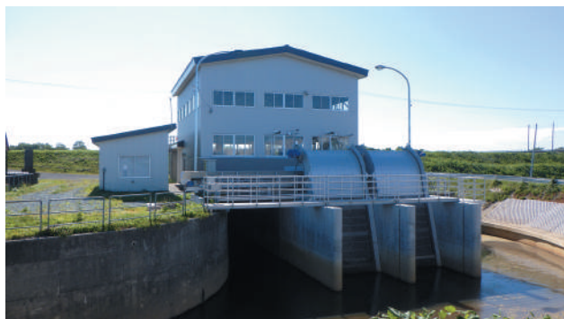
施設の維持管理労力の軽減や安全性向上を図るため老朽化した農業用施設を更新整備
