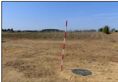
畑の端部に汲上枡を設置して暗渠からの排水を一時貯留
