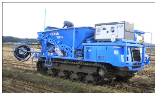
クローラ型専用機による施工状況
