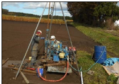
ボーリング調査で透水層を確認
