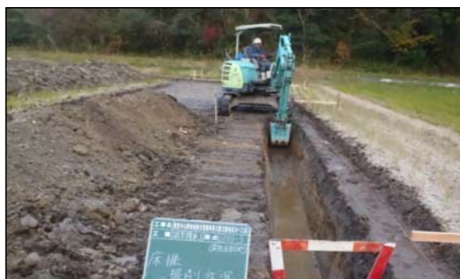
バックホウによる施工状況
