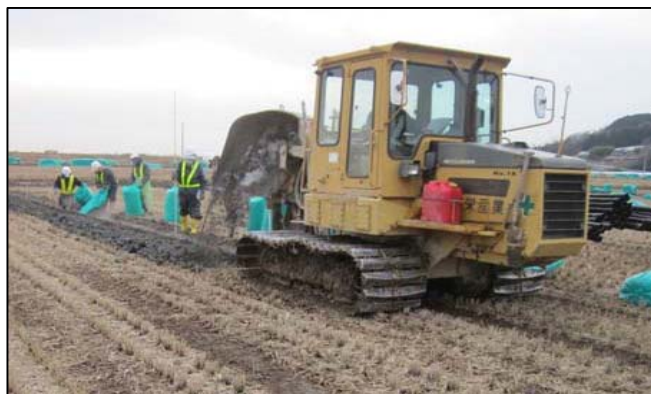
トレンチャによる施工状況
