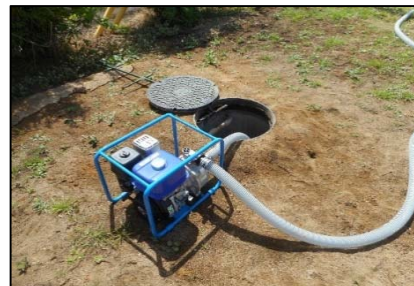
エンジンポンプで排水路へ汲み上げる
