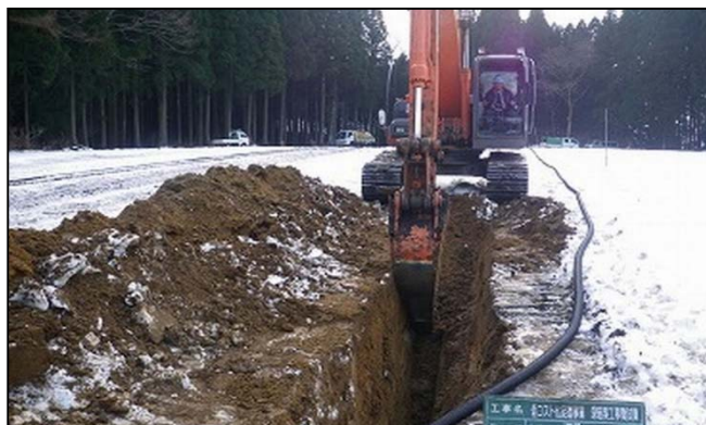
専用バケットによる施工状況
