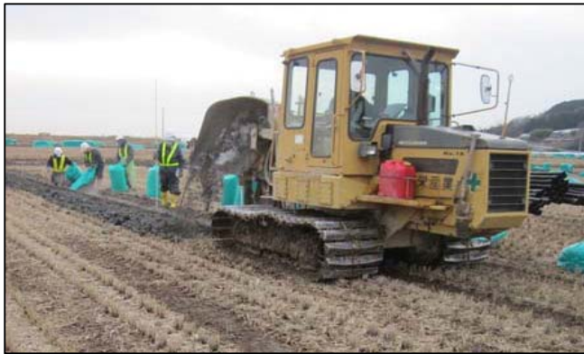
トレンチャによる施工状況
