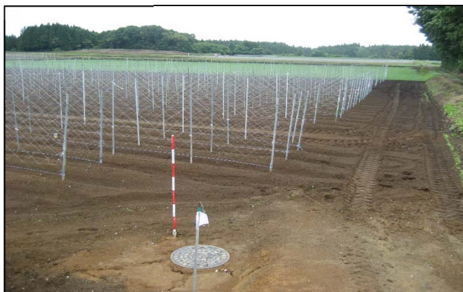
深暗渠施工後
