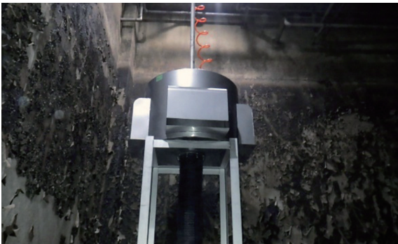
上澄水排水装置の更新 農業集落排水事業
