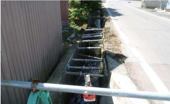
排水路の整備前 中山間地域総合整備事業
