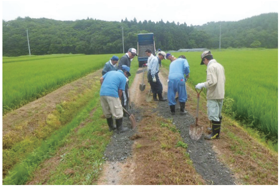
農道の砂利敷き みすがさわ 水ヶ沢農地保全の会（平内町）
