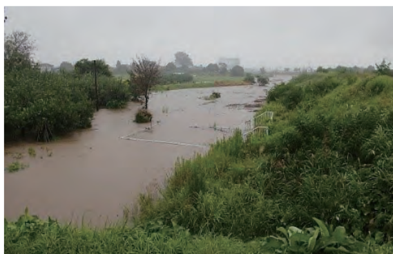
整備前（湛水被害状況）
