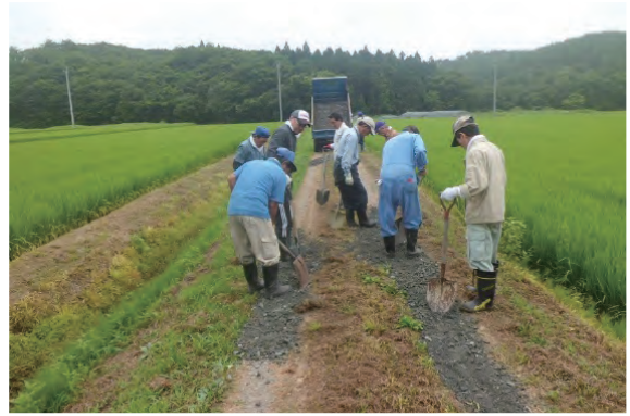
農道の砂利敷き みずがさわ 水ヶ沢農地保全の会（平内町）
