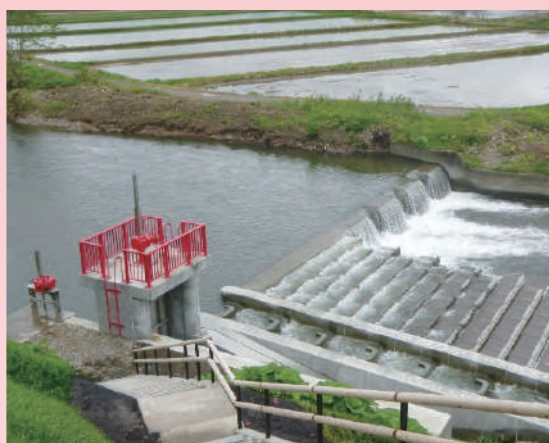
頭首工の整備 舞手頭首工地区（田子町）
