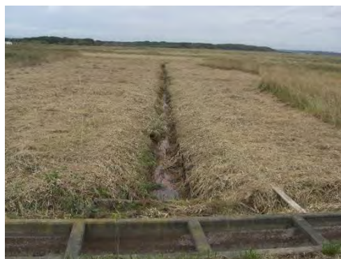
整備前(土水路)
