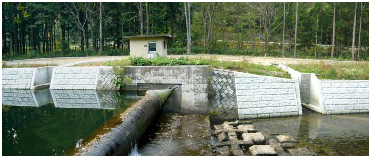
魚道工設置状況
