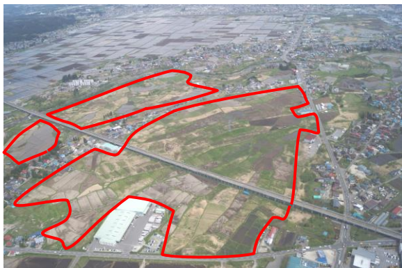
【整備前】荒川中部地区（青森市）
