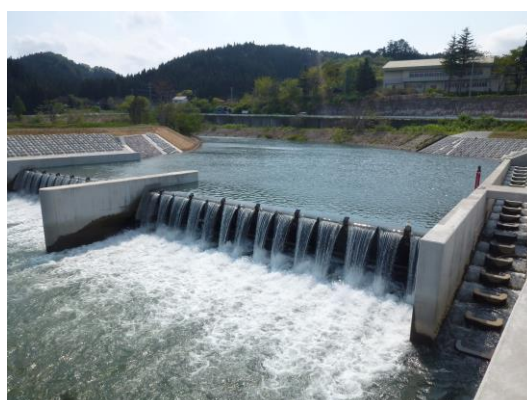
頭首工 鱒ヶ沢堰地区（鱒ヶ沢町）
