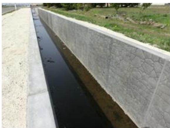
整備された幹線用水路 庄司川上堰幹線用水路地区（平川市）
