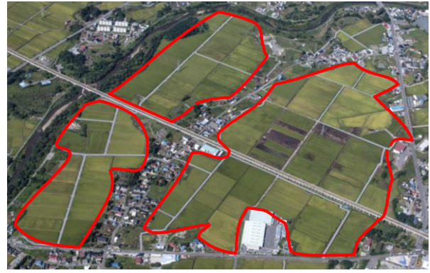
【整備後】荒川中部地区（青森市）
