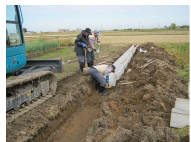
水路の更新 原田グリーンサークル(平川市)
