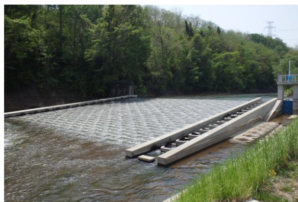
頭首工 上川原地区（三戸町）
