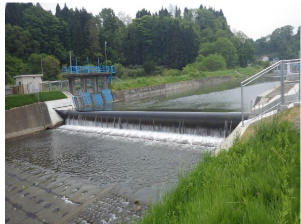
天満下頭首工地区 (五戸町)
