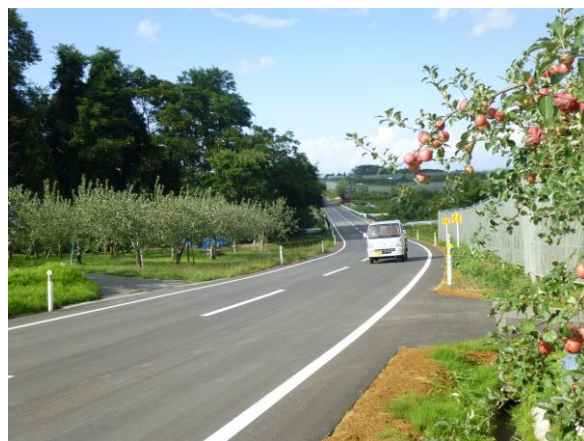
樹園地に更新整備された農道 高杉・貝沢地区（弘前市）
