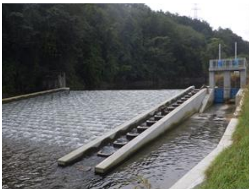
生態系に配慮した魚道整備 上川原地区（三戸町）
