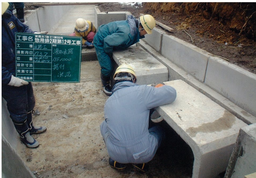
湾処① 側溝布設状況
