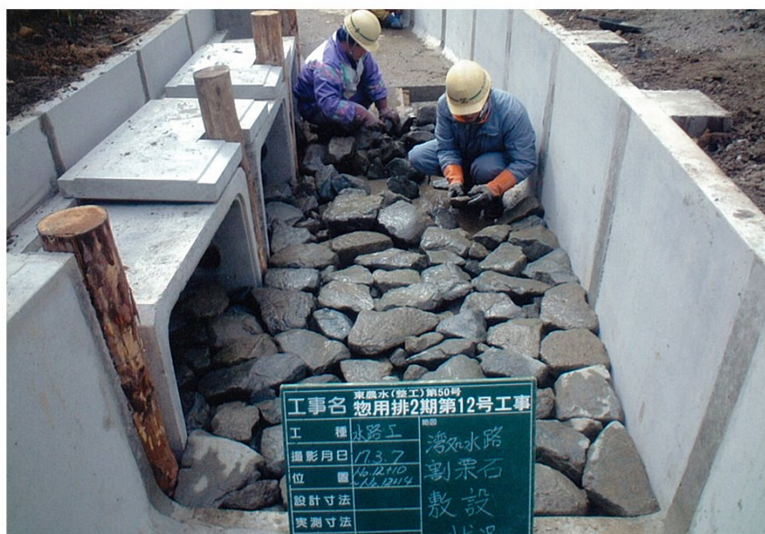
湾処① 割栗石敷設状況
