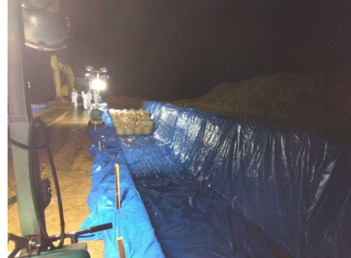
⑥2023. 03. 26 (23 時頃) 埋却作業の様子 2
