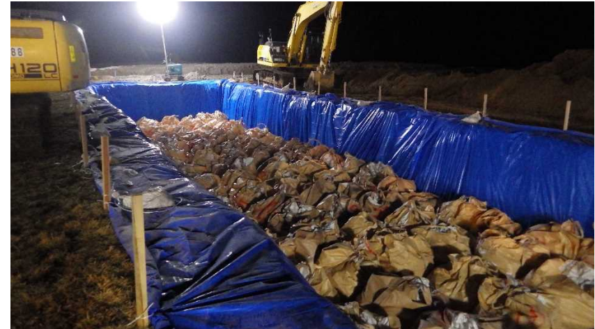
④2022. 12. 27 (17-翌1時) 埋却作業の様子
