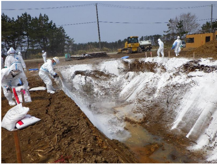
①2022. 4. 10 (11 時頃) 埋却溝 (二本目) の状況
