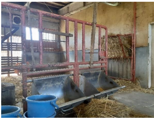
扉が内側に開いている状態
