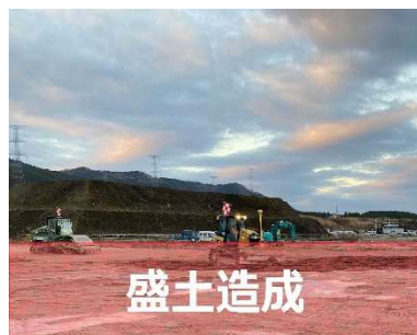
盛土造成 建設作業エリアの造成
