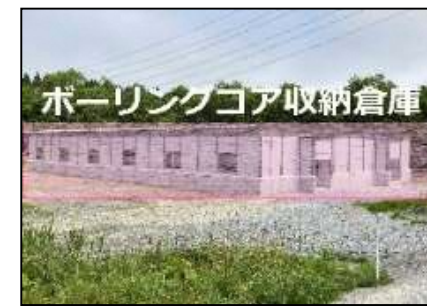
ボーリングコア収納倉庫の増設
