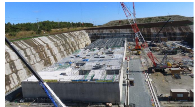
3号埋設施設の様子(2023年10月)
