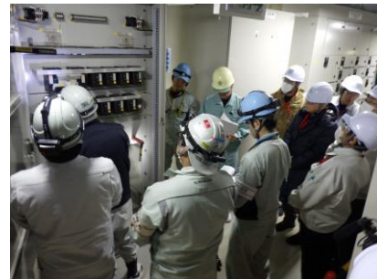
協力会社社員が分電盤の点検作業を行っている様子
