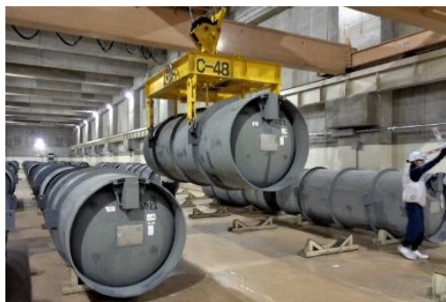
運転再開のため原料シリンダを吊り上げる様子
