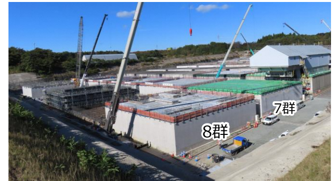
1号埋設施設7,8群の様子(2023年10月)
