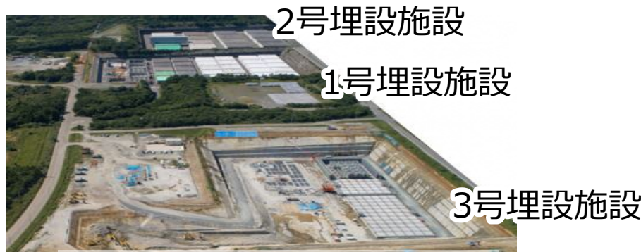
低レベル放射性廃棄物埋設施設全景
