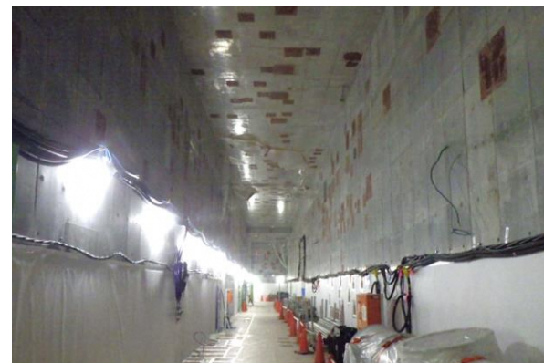
地下3階の工事状況(2023年12月)
