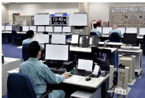
中央制御室での運転状況監視
