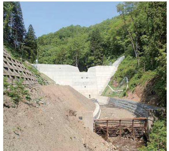
押付沢砂防総合流域防災事業（六ヶ所村）
