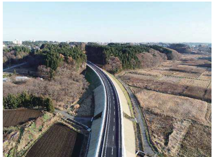
八戸野辺地線駒沢バイパス（三沢市） H30.11.30供用
