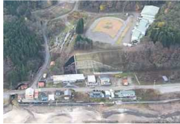
釣屋浜1号区域急傾斜地崩壊対策事業(むつ市釣屋浜) 植生法柵工
