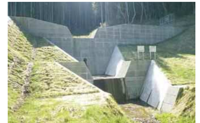
蛇浦川通常砂防事業(2号砂防堰堤)
