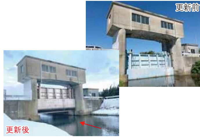
田名部川河川メンテナンス事業(田名部川分流水門)
