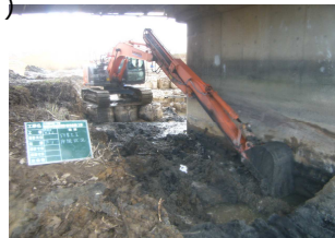
水替え工(暗渠排水管)
