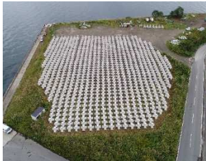
2工区製作ヤード
