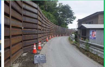
防護柵完成全景
