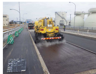
【分解促進型タックコートの施工】
