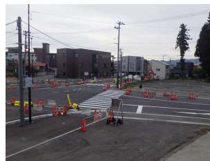
作業ヤード規制
