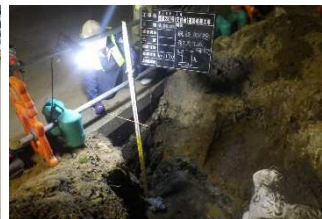
水道管の立会い
