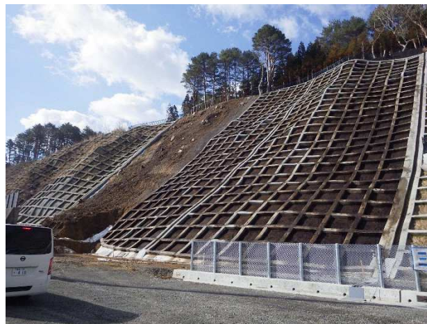
令和3年度施工完成写真
