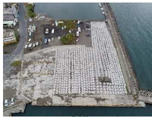
1工区製作ヤード
