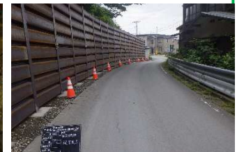
防護柵完成全景
