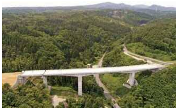
国道279号 二枚橋バイパス
