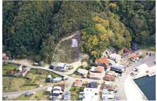
九艘泊区域急傾斜地崩壊対策事業(むつ市脇野沢九艘泊) 現場打吹付法砕工
