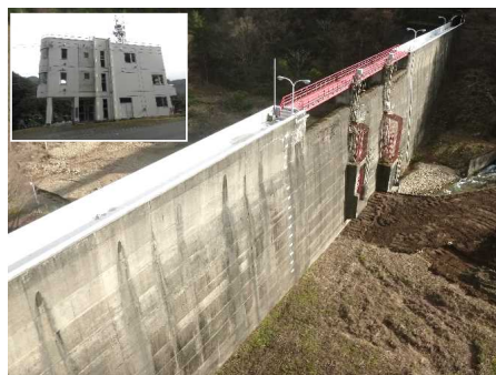
防災ダム事業 夏坂ダム地区（田子町、R3～R8） 防災ダムの施設改修
