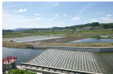
農業水利施設魚道整備促進事業 舞手地区（田子町、H29～R3） 魚道の整備
