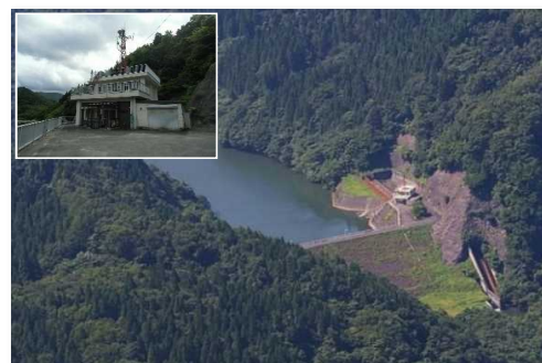
防災ダム事業 花木ダム地区（田子町、R4～R8） 防災ダムの施設改修（整備前）
