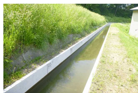
ため池等整備事業（用排水施設整備） 同心町地区（三戸町、R1～R4） 農業用水路の改修
