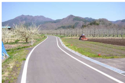
中山間地域総合整備事業 三戸地区（三戸町、H26～R6） 農道の整備
