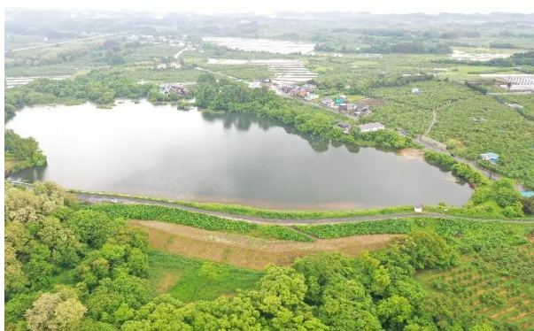
ため池等整備事業 (高野大溜池地区 五所川原市 R1～R3)
