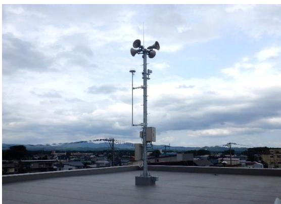
農地耕作条件整備事業 基地局設置 (五所川原スマート地区 五所川原市 R3~R4)
