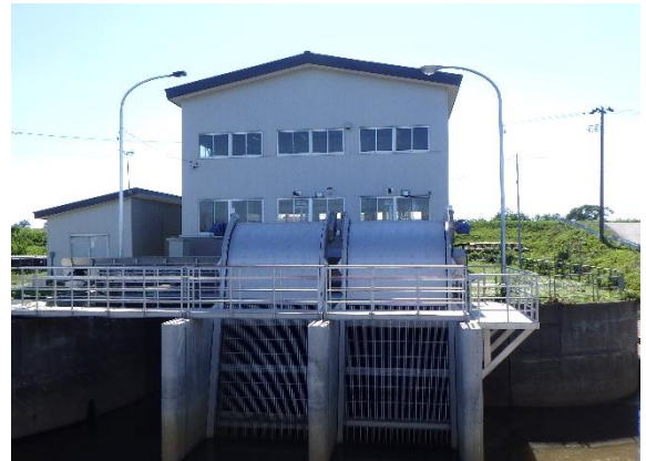
県営小田川南部地区農業水利施設保全合理化事業により整備を行った金木排水機場
