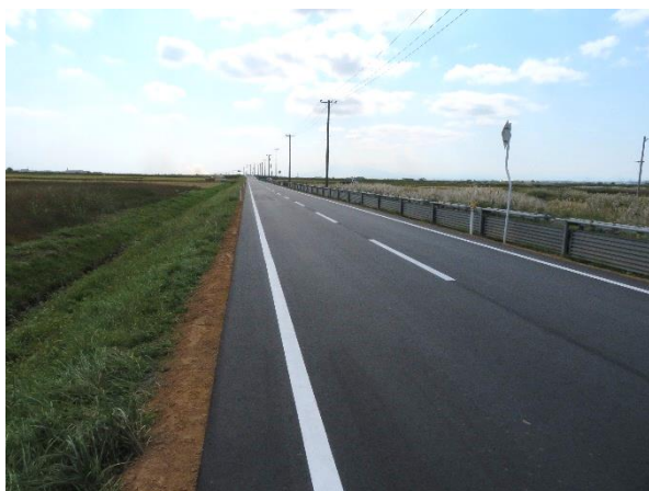
通作条件整備事業 舗装工 (五所川原第二地区 中泊町 H29～R6)
