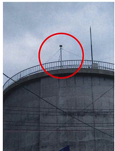
若宮排水槽の上部に設置した RTK-GNSS固定基地局
