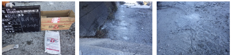
【1次破碎状況（静的破碎材）】
