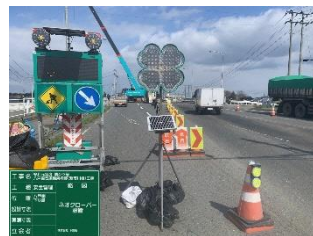
視認性の良い交通規制材の設置
