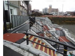
完成【Bブロック】起点側
