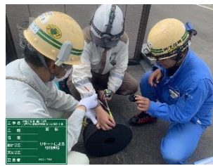
遠隔臨場による施工検査
