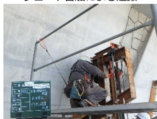
分割小型化による人力施工
