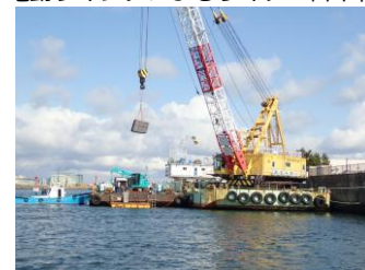
15t吊起重機船積込作業
