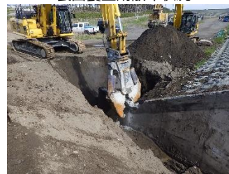
既設堤防取壊し状況
