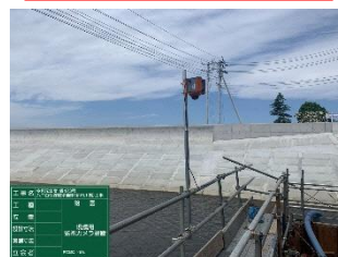
カメラ設置による現場把握
