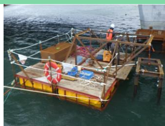
フロート台船による運搬
