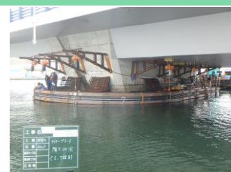
電動ウインチによるライナー降下作業
