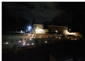
完成 夜間【Bブロック】全景
