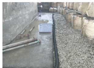
水替え工(暗渠排水管)
