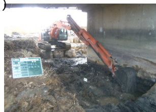
水替え工(暗渠排水管)
