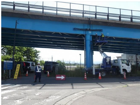
点検状況写真
