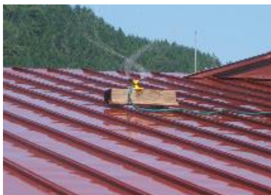
屋根への散水
